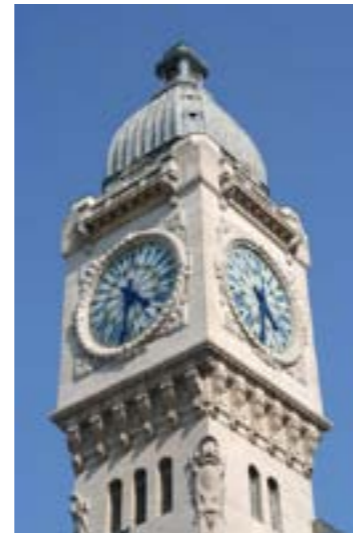
DETAIL GARE DE LYON
