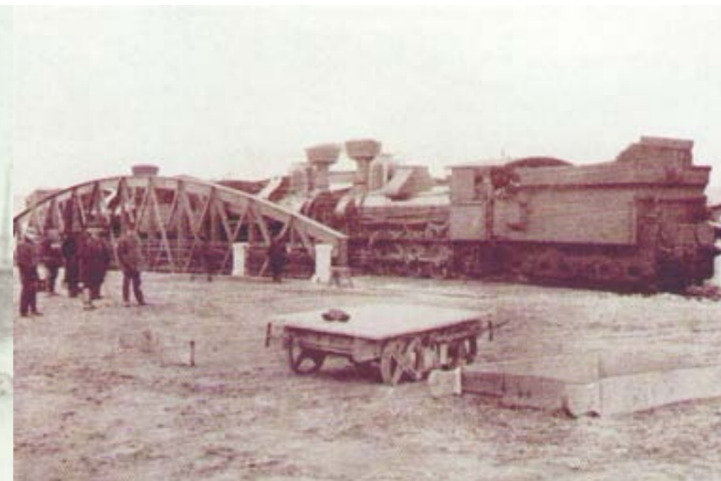
ZKOUŠKA MOSTU PŘÍSTAVNÍ VLEČKY
