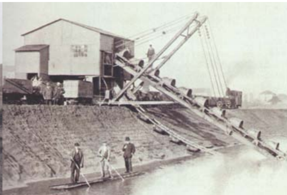
STAVBA VOROVÉHO PŘÍSTAVU
