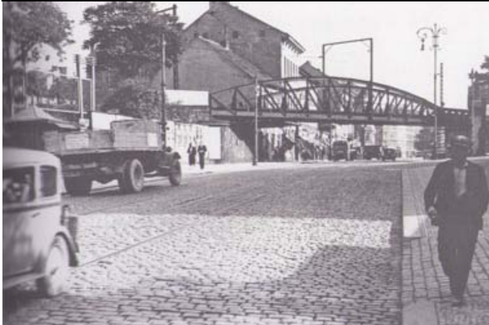
ŽELEZNIČNÍ MOST PŘES NÁDRAŽNÍ TŘIDU - 1935
