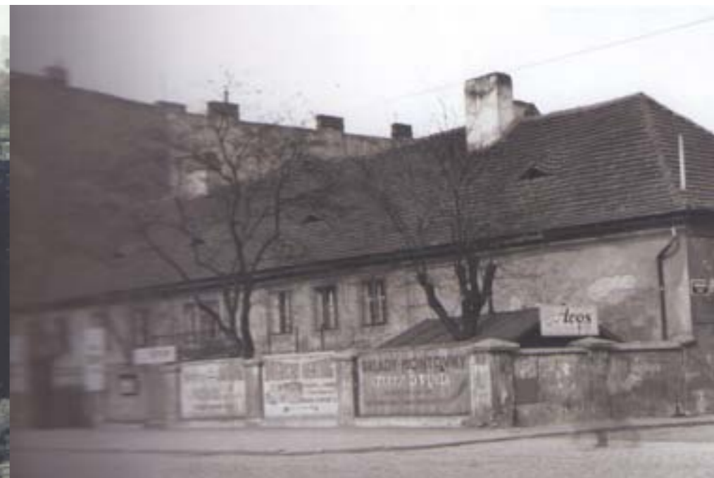
ROH ULICE NÁDRAŽNÍ A U ŽELEZNIČNÍHO MOSTU
