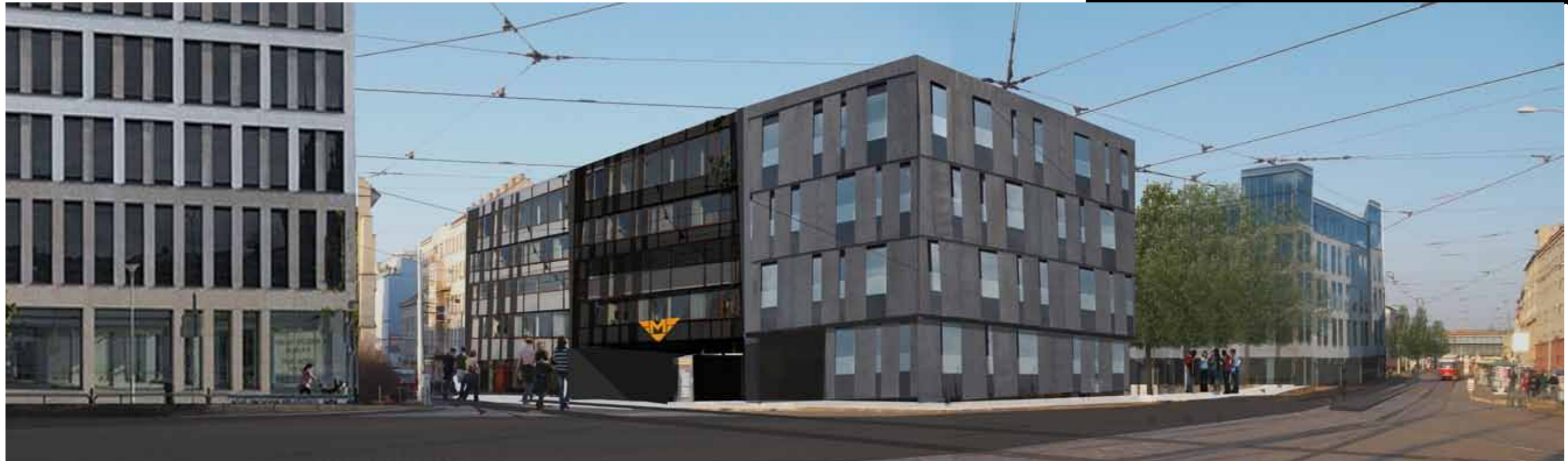
DOSTAVBA KŘIŽOVATKY PALMOVKA. SYNAGOGA (ZA NOVOU ZÁSTAVBOU) ZÍSKÁVÁ VLASTNÍ INTIMNÍ PROSTOR.
