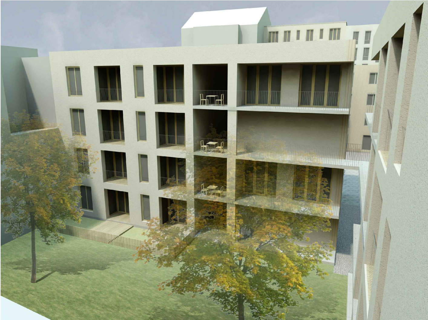
pohled do dvora B z jihu
