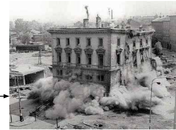
demolice budovy nádraží Těšnov
