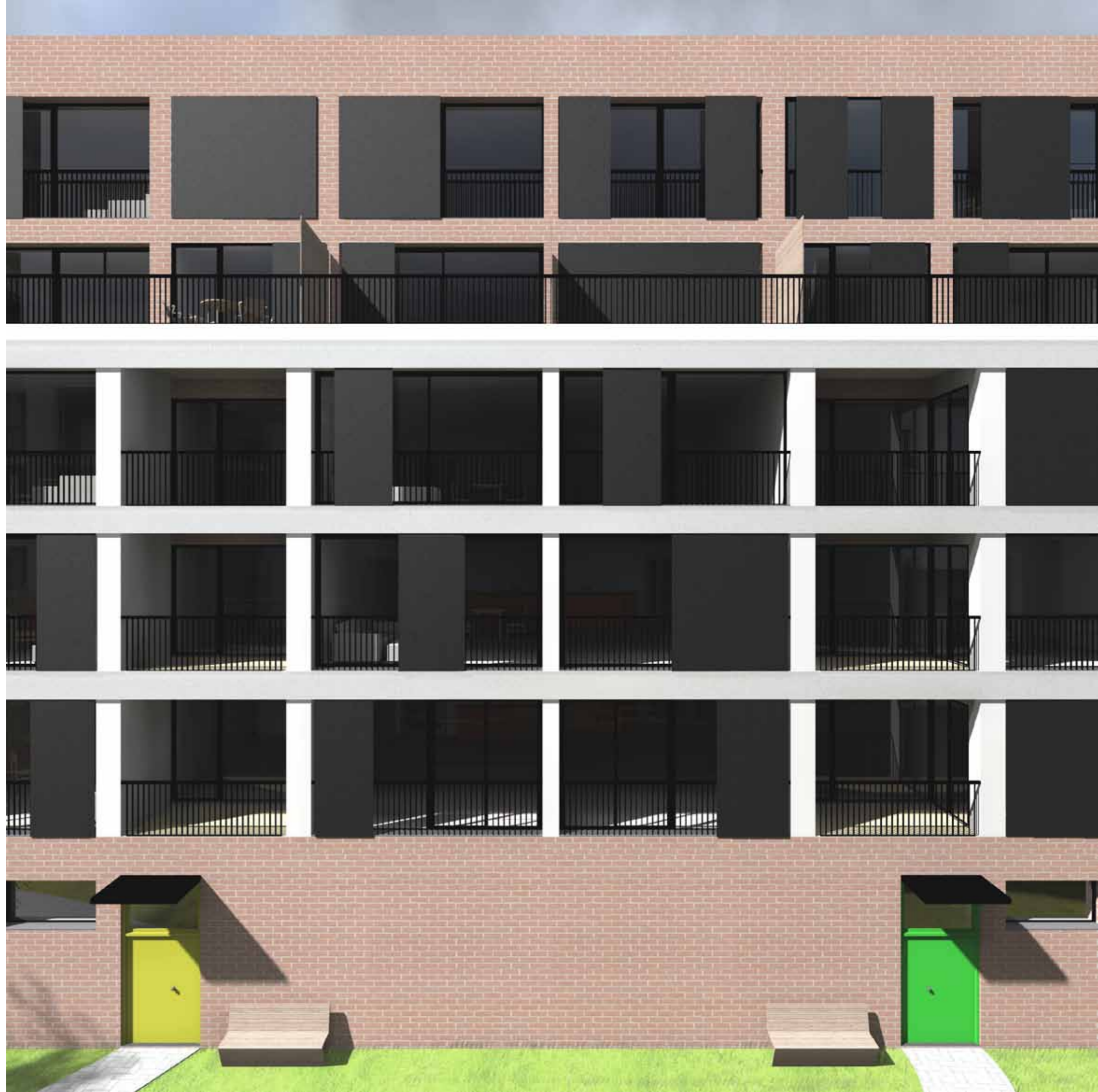
VÝCHODNÍ FASÁDA - POHLED DO VNITROBLOKU
