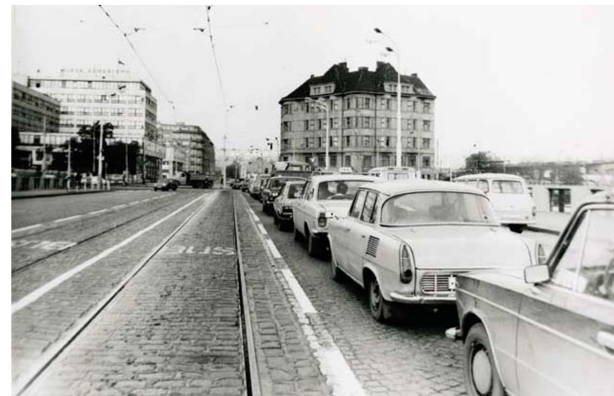
Obě strany bubenského předmostí Hlávkova mostu před stavbou severojižní magistrály v roce 1972 s průhledem do Bubenské ulice. Na pravé straně je mohutný dům čp. 463
