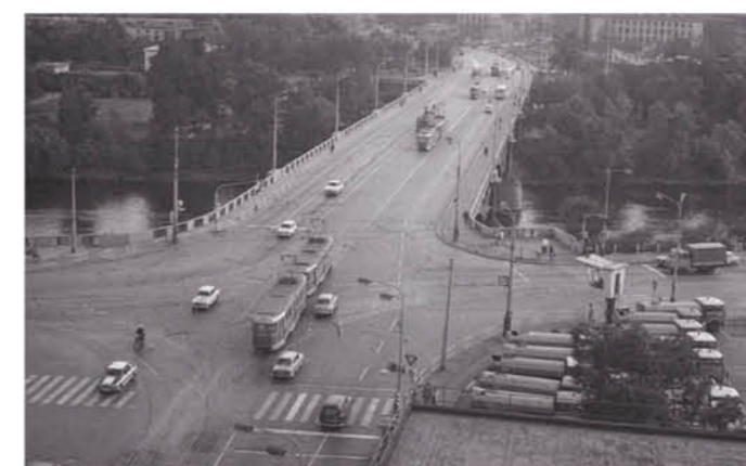
Pohled na předmostí Hlávkova mostu z budovy Elektrických podniků před přestavbou (1972) archiv Dopravního podniku hl. m. Prahy
