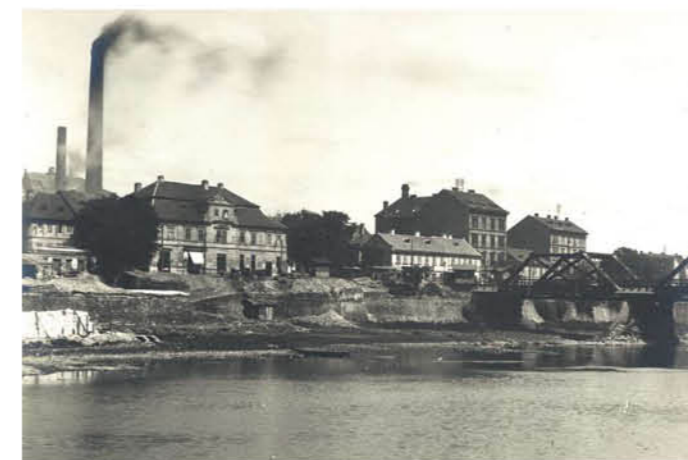
Bubenské nábřeží. Okolí vyústění ulice kolmé k břehu ve směru dnešního Hlávkova mostu. Na tom místě však stojí prozatím jen dřevěný provizorní most na Štvanici. Foto J. Kříženecký, 1908. Muzeum hl. m. Prahy
