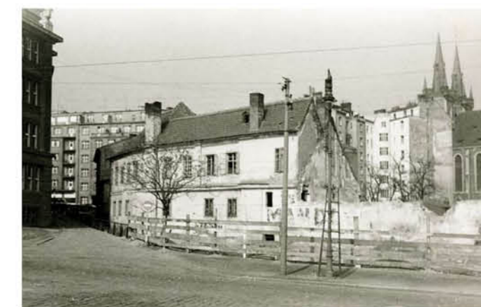
Torzo bubenského pivovaru, bývalého Bubenského dvora, těsně před demolicí. Foto E. Hnilička, 1959, Muzeum hl. m. Prahy
