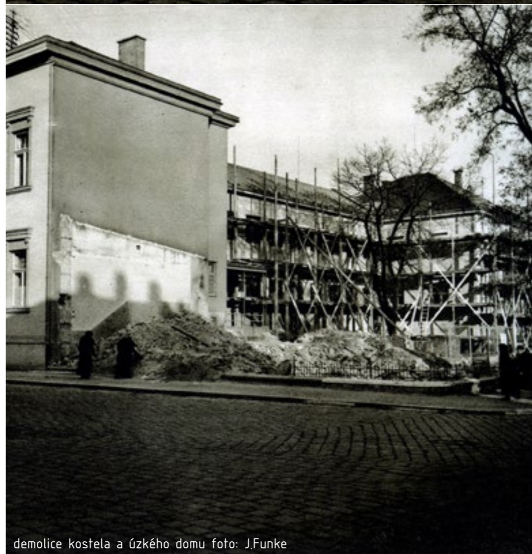
těsně před demolicí /1941/ foto: J.Funke
