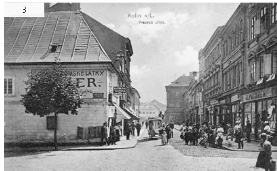
Pražská /budovy vlevo demolovány 1972/, 1904
