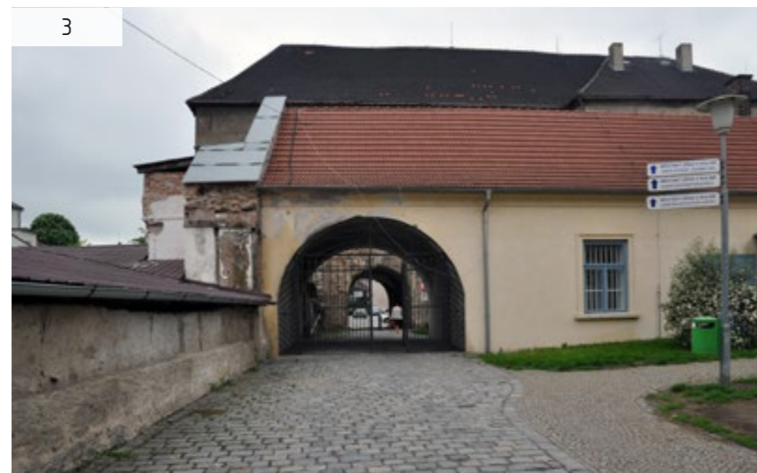
brána na malé nádvoří /vlevo sanované ječné pudy/
