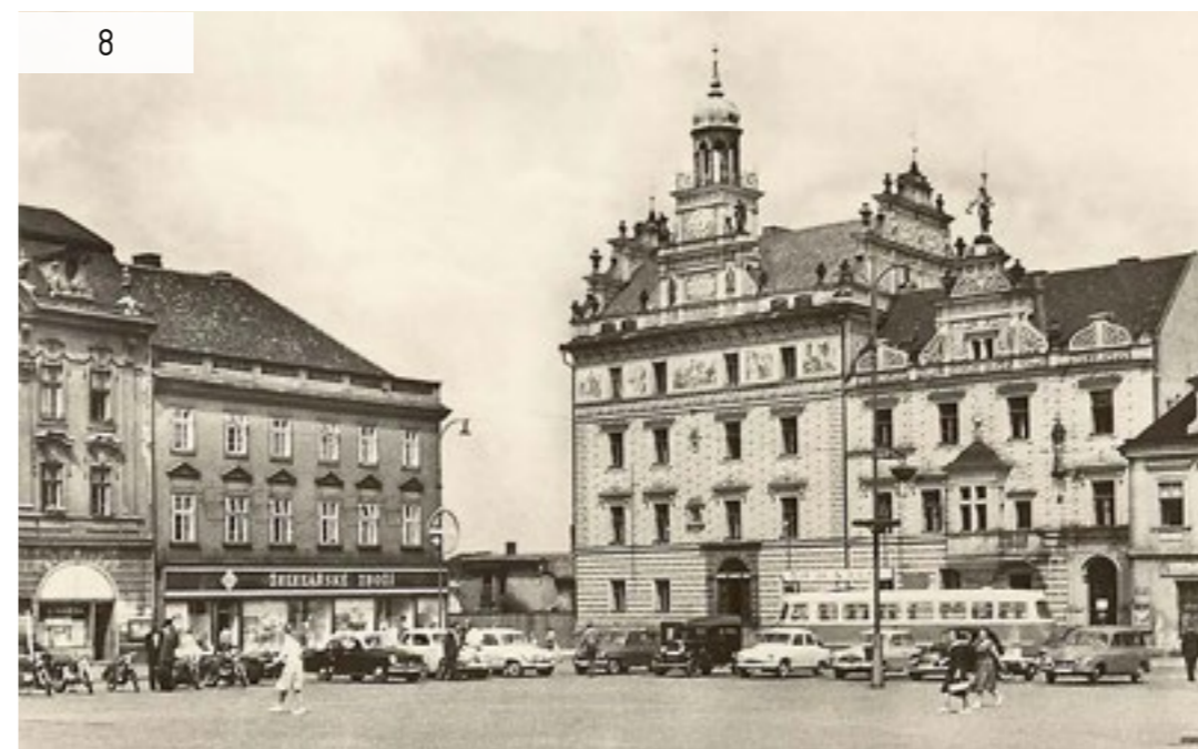
Karlovo náměstí po demolici měšťanského pivovaru, 60. léta
