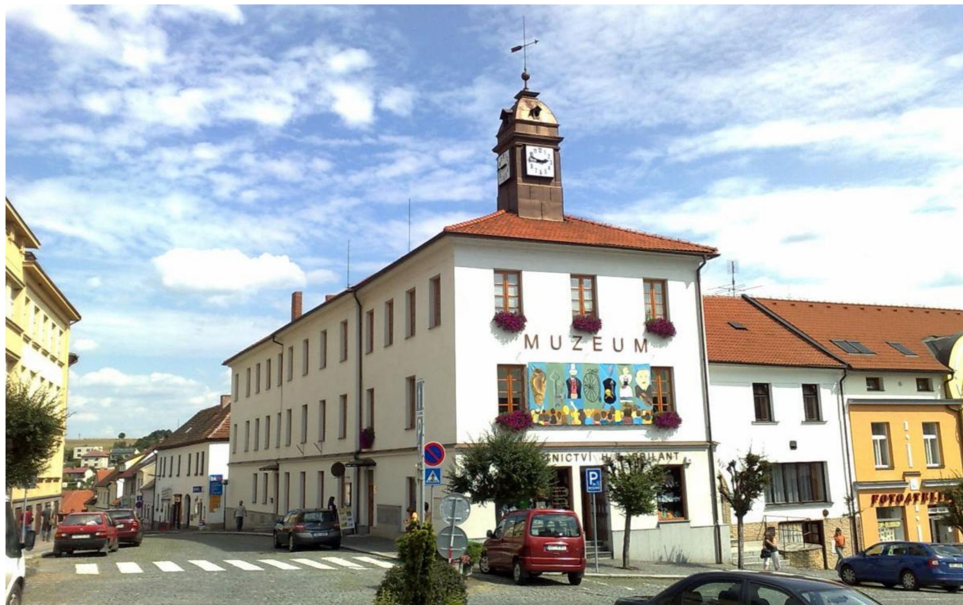
_ Podoba zrekonstruované staré radnice
