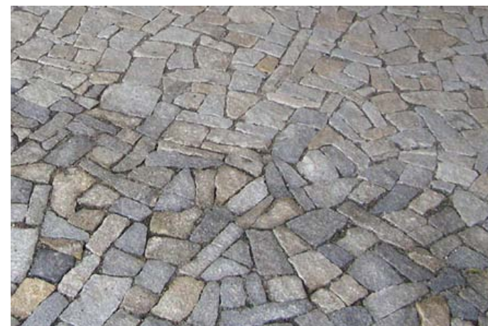
ŽULOVÁ DLAŽBA - ŠTÍPANÝ KÁMEN ZKLIDNĚNÝ ÚSEK VOZOVKY V ULICI KODAŇSKÁ A BEZEJMENNÁ
