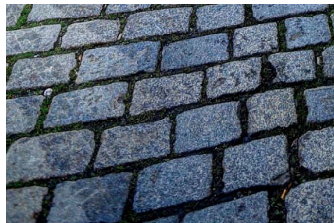
ŽULOVÁ DLAŽBA - KOSTKY VOZOVKA V ULICI KRYMSKÁ
