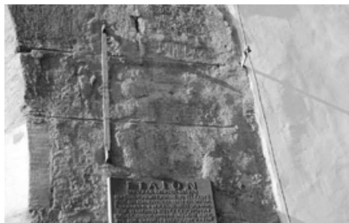
etalon pražského lokte na zdi Novoměstské radnice
