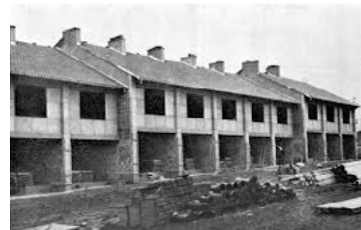
výstavba sídliště Solidarita
