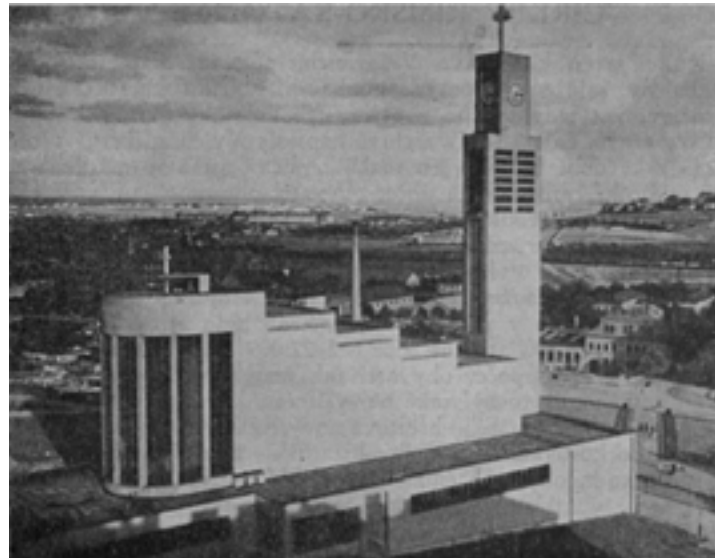
kostel sv. Václava v době výstavby výrazně převyšoval okolí
