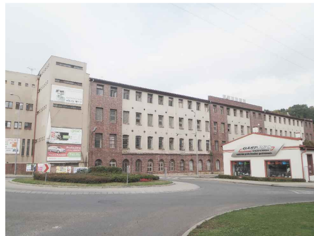
zkrachovalá textilní továrna
