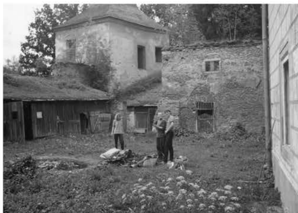
FOTOGRAFIE HOSPODÁŘSKÉHO OBJEKTU PŘED ZBOURÁNÍM V ROCE 1998
