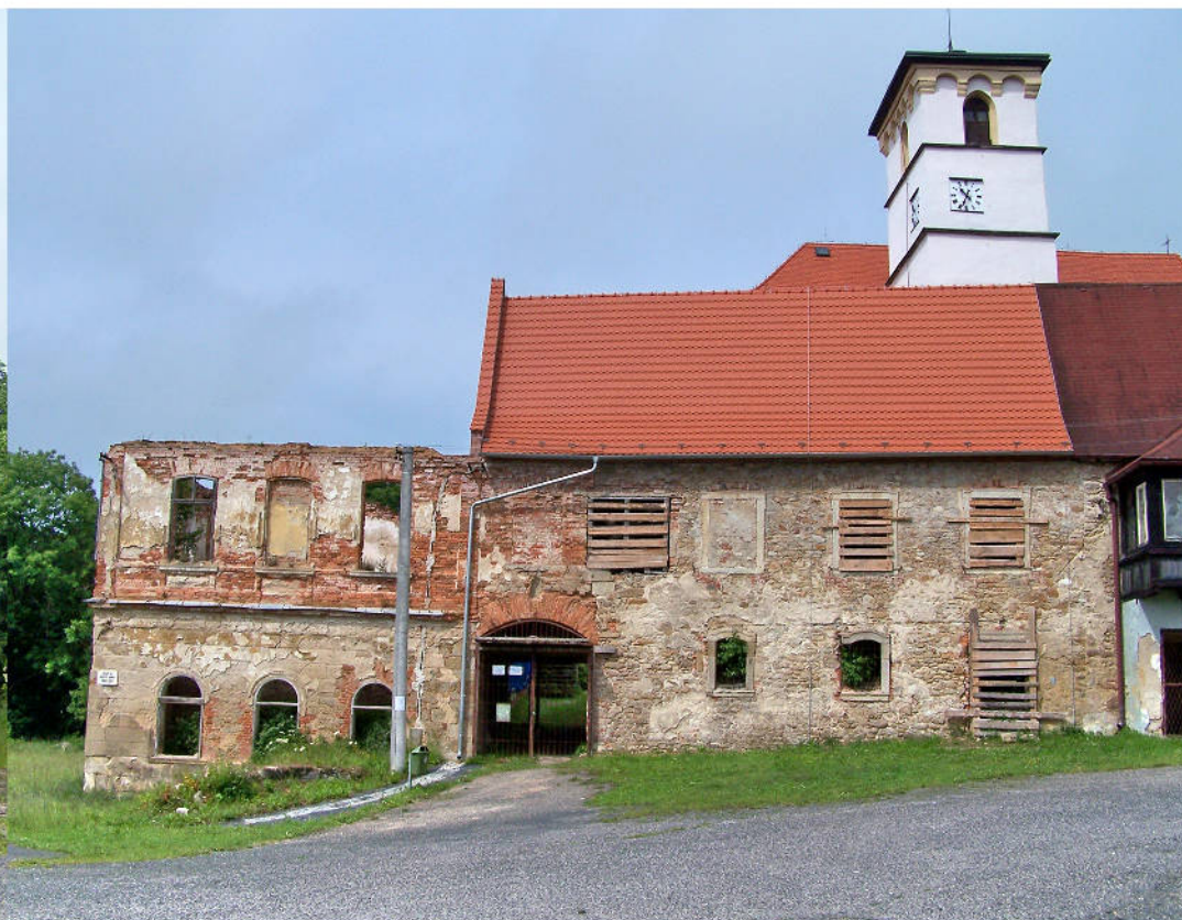
čiastočná oprava, nový krov, vstup do nádvorja areálu
