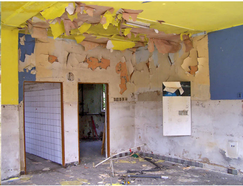
interiér severozápadnej časti
