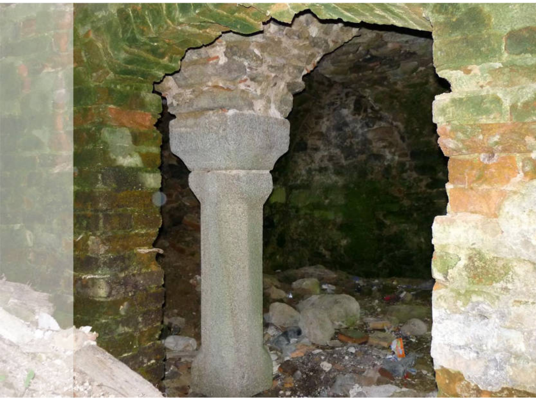
pozemné priestory pod južnou časťou
