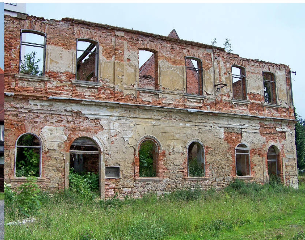
južná časť stavby, obvodové steny
