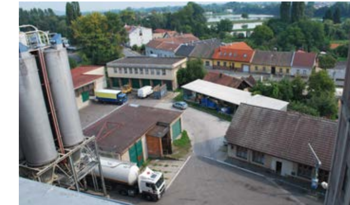
Pohled ze střechy mlýna na garáž a laboratoř
