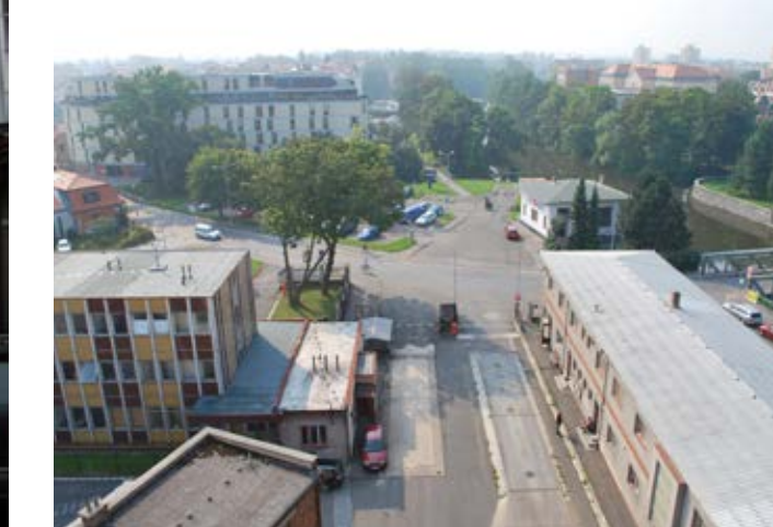
Pohled ze střechy mlýna do ulice Mezi mosty
