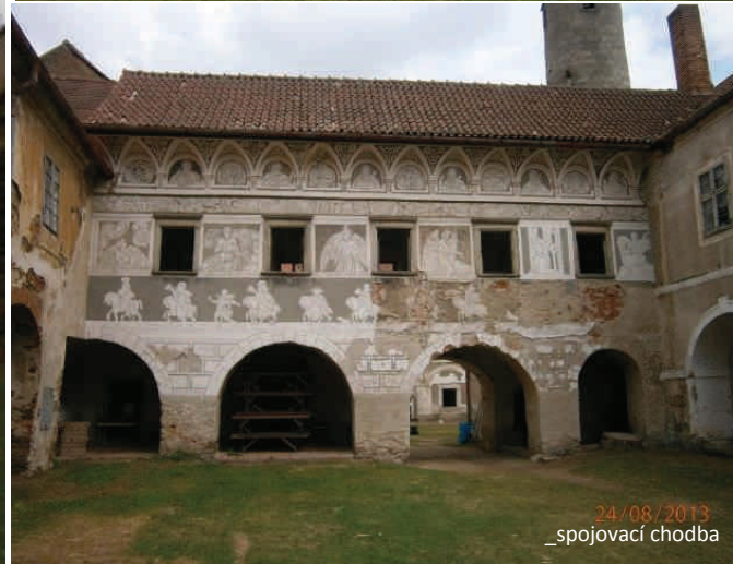
_východní stěna sýpky
