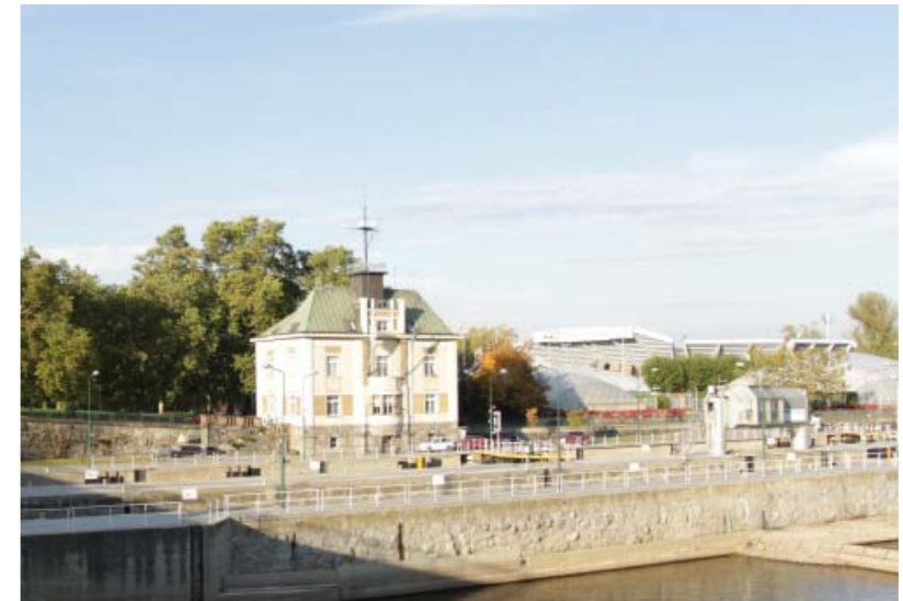
Dům zprávy povodí
