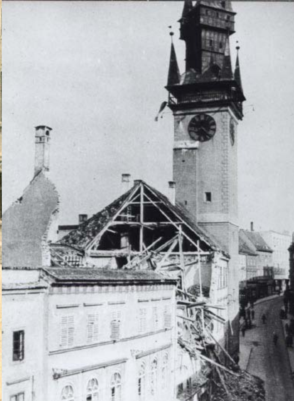
pohledy do ulice Obroková v průběhu bouracích prací z roku 1946
