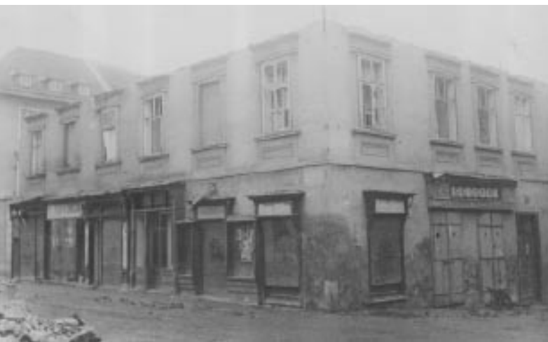
pohled na nároží Zelenářské a Elsingerovy ulice
