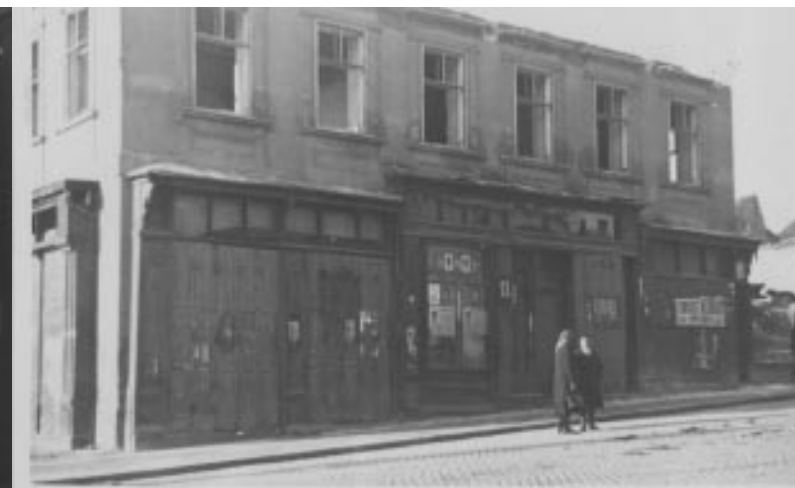
pohled z náměstí při ústí ulice Obroková
