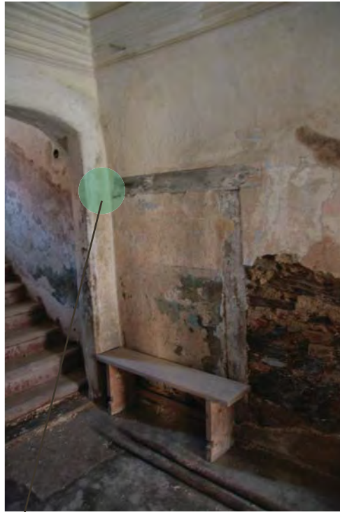
PATA SCHODIŠTĚ ZASAHUJÍCÍ DO DVEŘÍ
