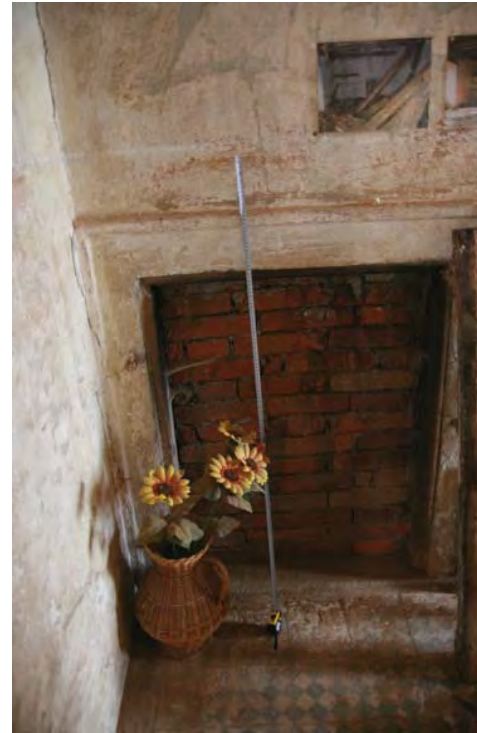
OSAZENÍ PŘÍKLÁDACÍHO PORTÁLKU BEZ ZAPUŠTĚNÍ DO STĚNY
