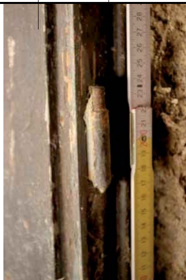
Moderní pant vnitřního okna 3B
