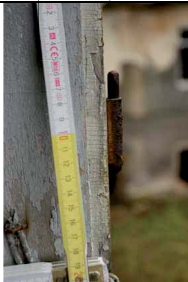
Vnější moderní pant
