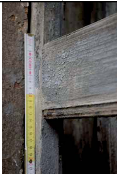
Profil poutce vnějšího okenního rámu
