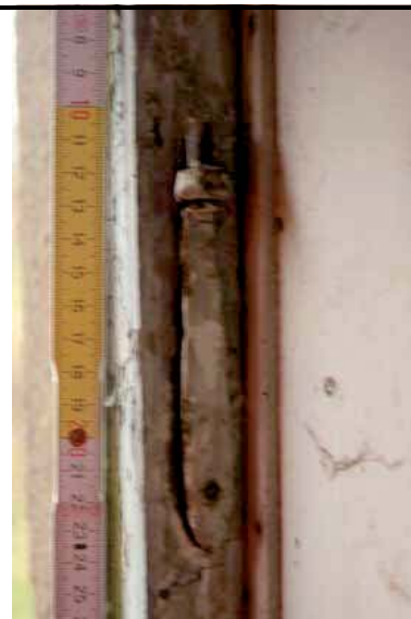
Barokní trnový pant s ozdobnou kytičkou.
