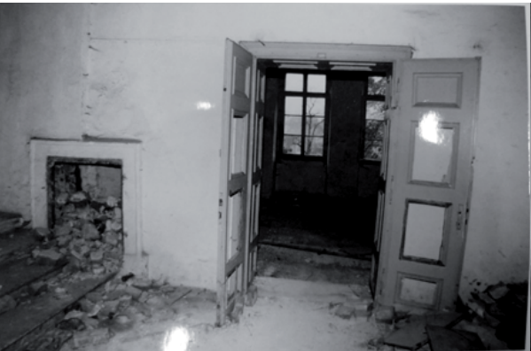
Kamenné ostění topeniště a pohled na repliku barokních dveří.
