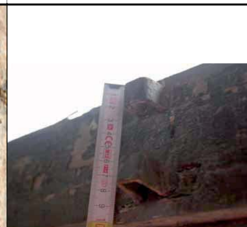
Rozdílné vysychání dřeva na vnitřním rámu.
