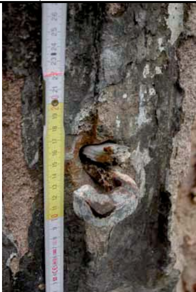
Skoba na uchycení mříže v kamenném ostění (čelní pohled)
