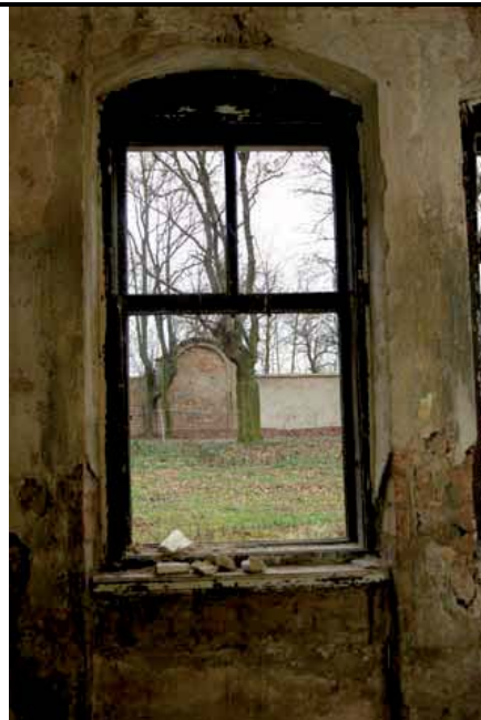
Vnitřní pohled na okno
