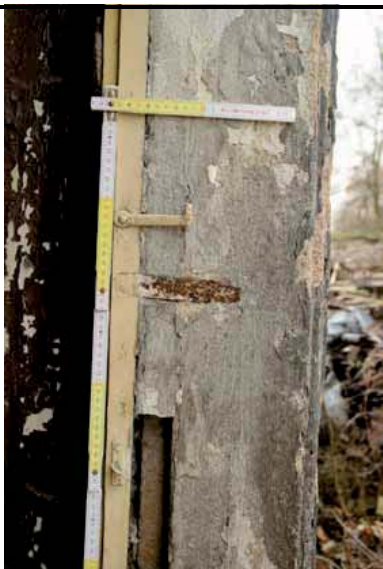
Ukotvení rámu do kamenného ostění
