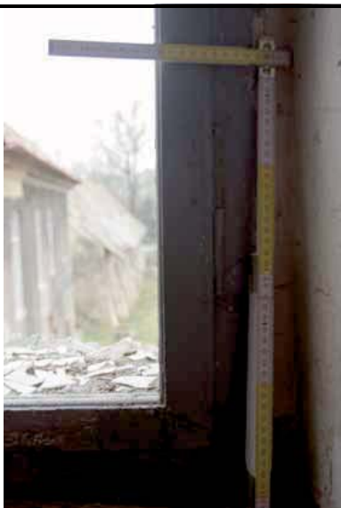
Pozůstatky vnitřního okenního křídla, kužilkový pant (6B)
