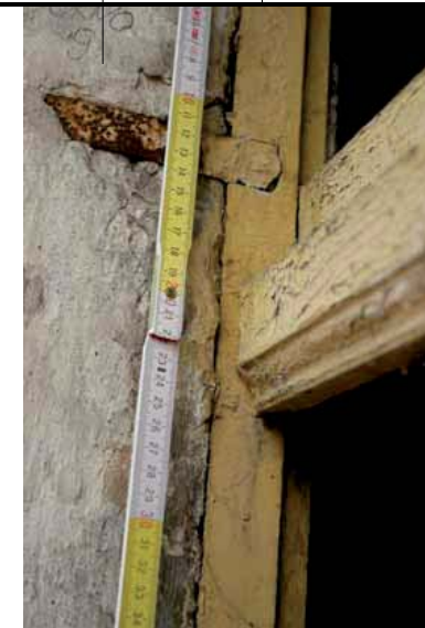
Profilovaný poutec vnějšího rámu - pohled z exteriéru
