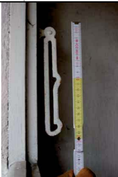
Zajištění okenního křídla
