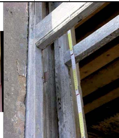
Rozdílné vysychání dřeva na vnitřním rámu.
