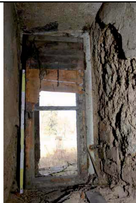
Vnitřní pohled na okno
