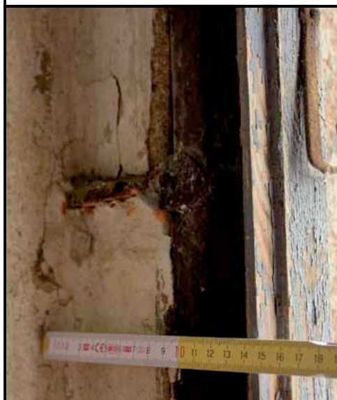
Uchycení vnějšího rámu do ostění.
