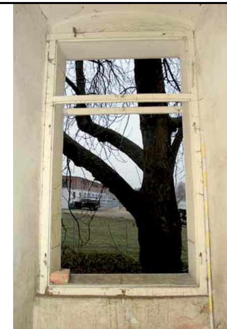
Vnitřní pohled na okno
