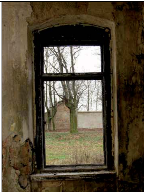
Vnitřní pohled na okno
