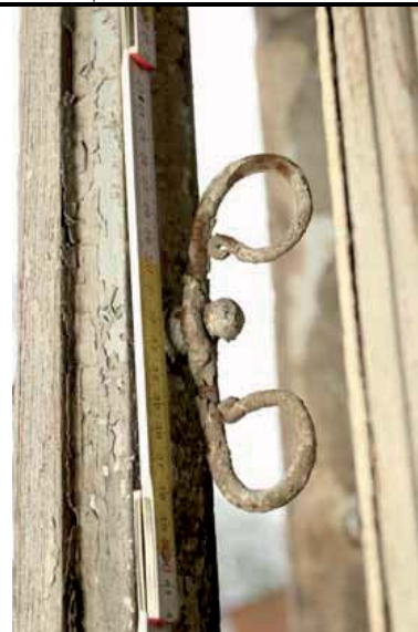
Barokní obrtlík horního okenního křídla.
