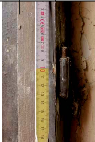
Vnitřní modení pant
