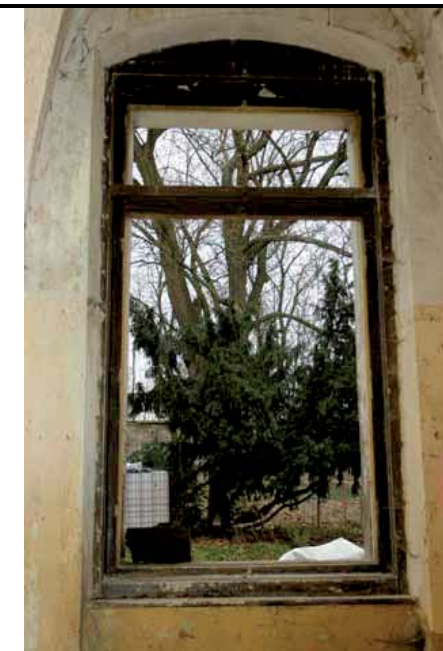
Vnitřní pohled na okno
