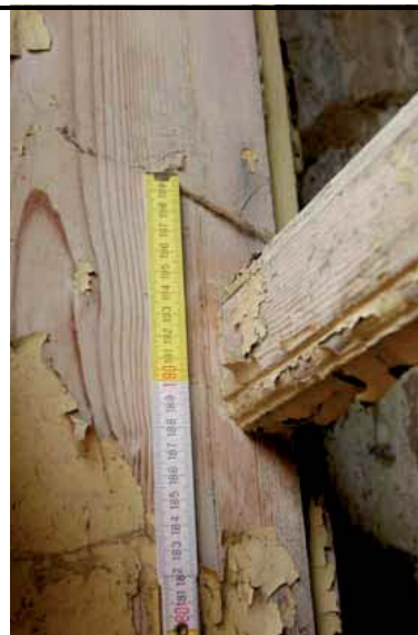
Ukotvení rámu do kamenného ostění
