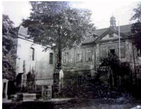
Pohled na severní fasádu jižního křídla zámku
