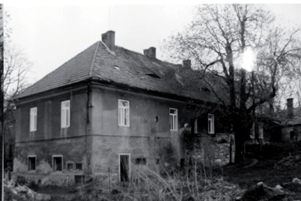
Západní křídlo zámku - nárožní pohled ze severozápadu.
