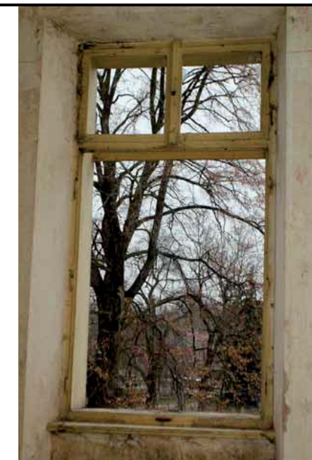
Vnitřní pohled na okno
