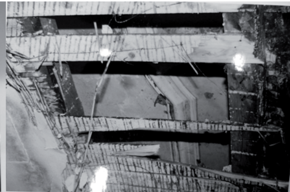
Průhled na starší strop v sále (č.13).
