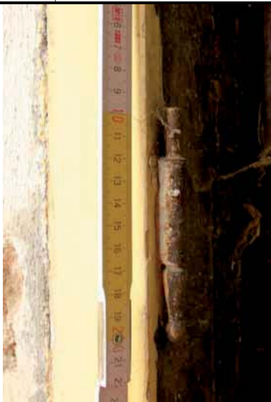
Kužilkový pant štíhlejší - vnější rám
