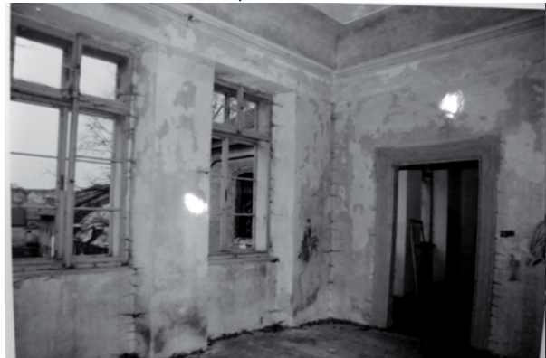
Okna v místnosti č.18 s průhledem do místnosti č.17.
