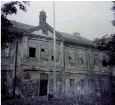
Pohled na severní fasádu jižního křídla zámku
