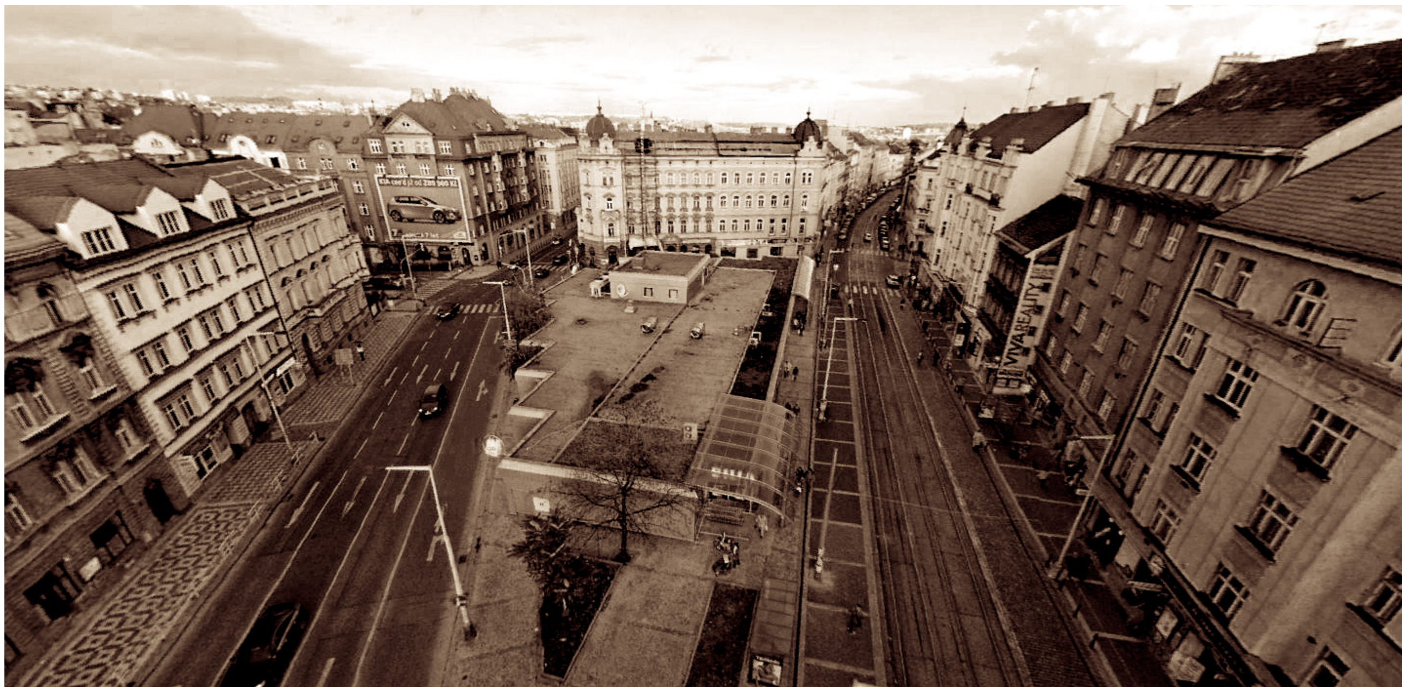
Letenské náměstí pohled směr Vltavská - současný stav
