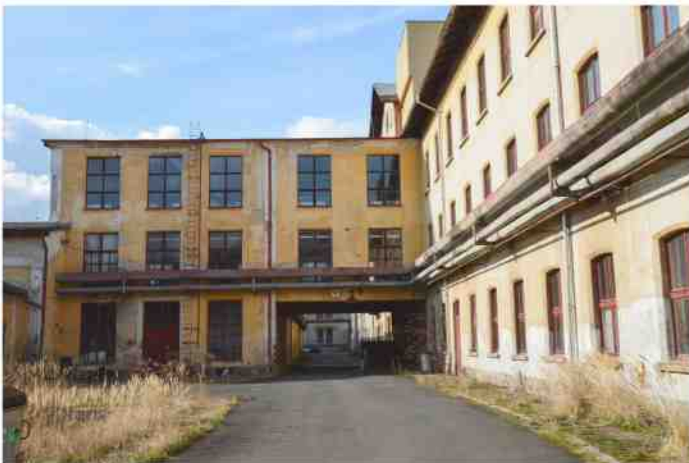
východní fasáda objektu bývalé kotelny
