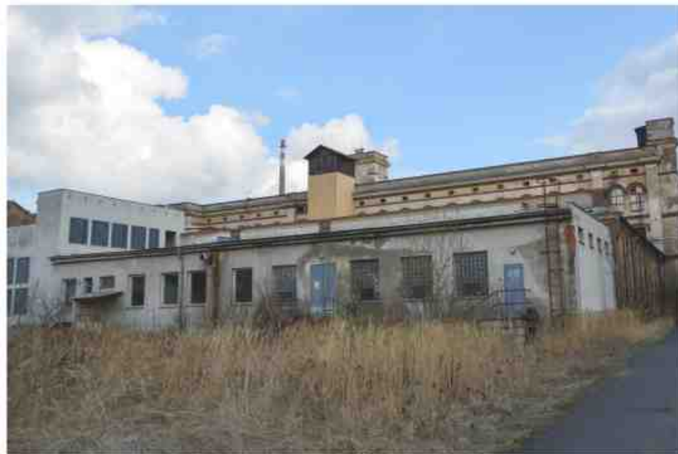
pohled na pilu a halu pro skladování příže
