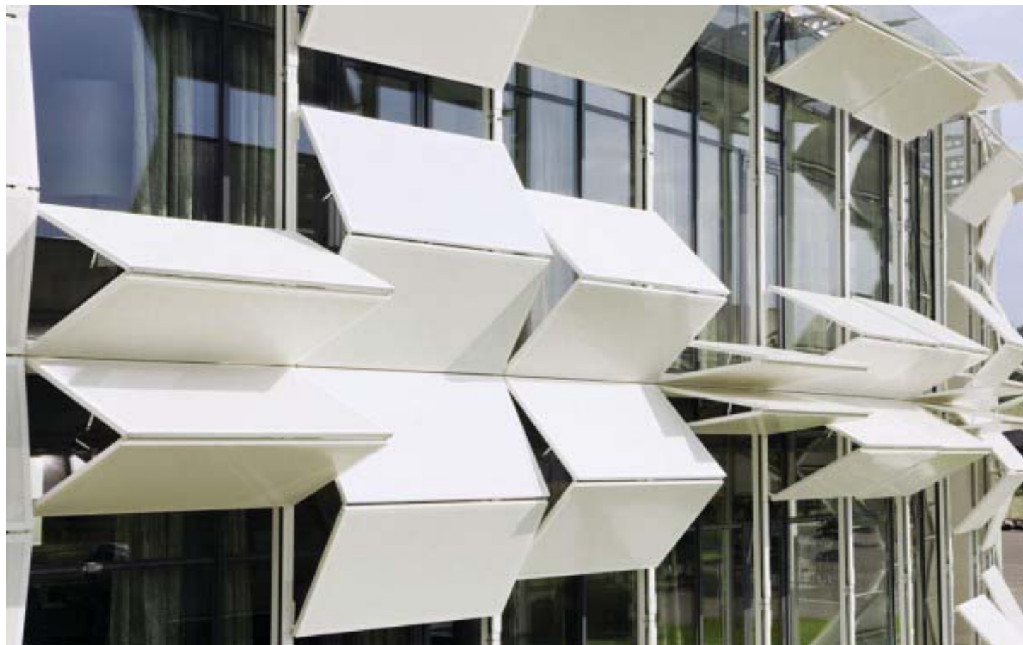
Vnější stínidla na jižní fasádě operačního oddělení
