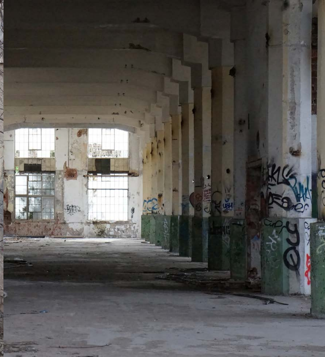
Hala ČKD "Kostel"
