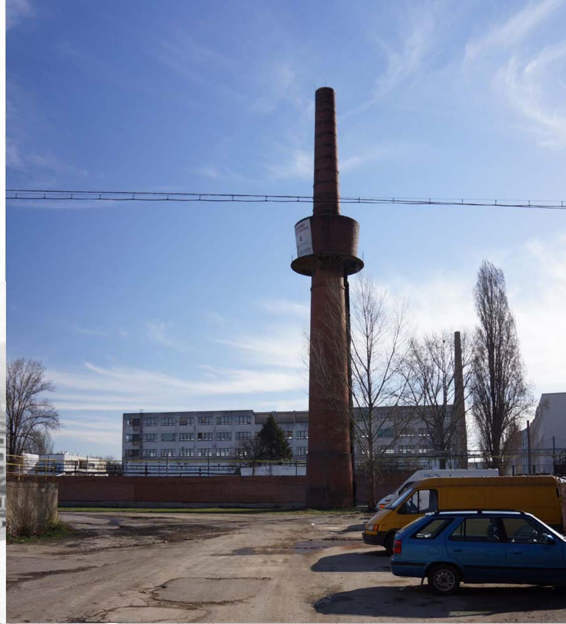
Ulice Kolbenova, Nosič infrastruktury
