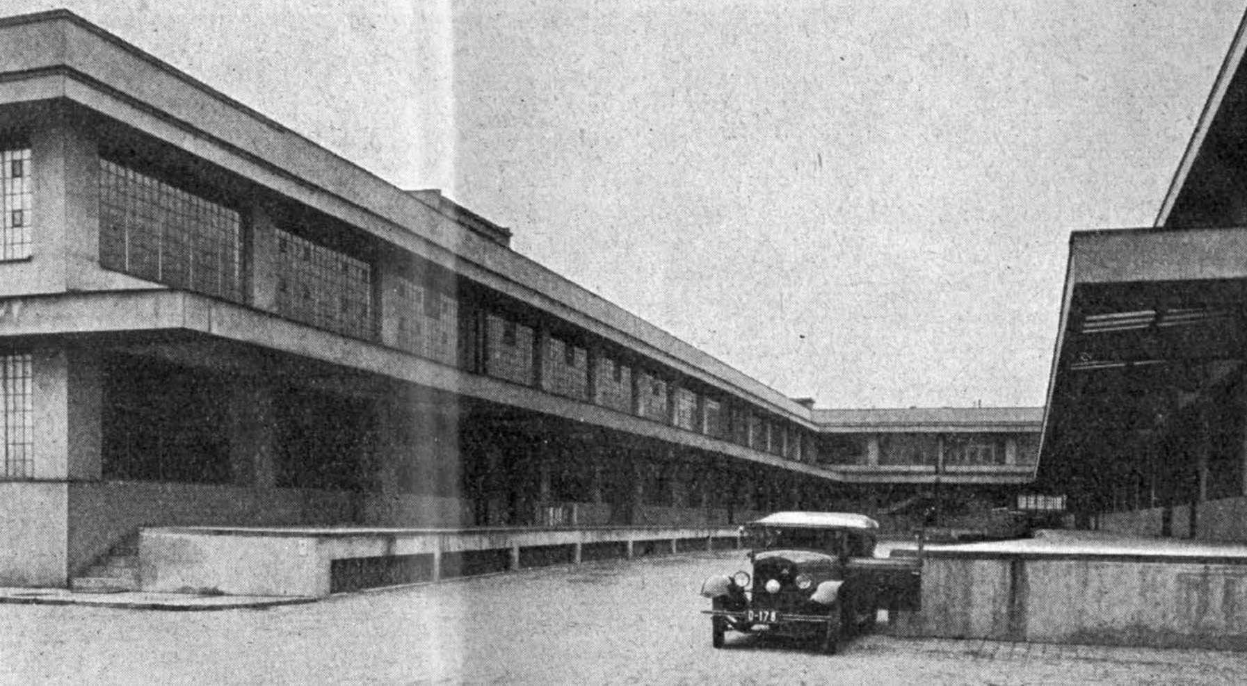
Areál Praga, Hala E Bývalý sklad Ministerstva pošt a spojů
