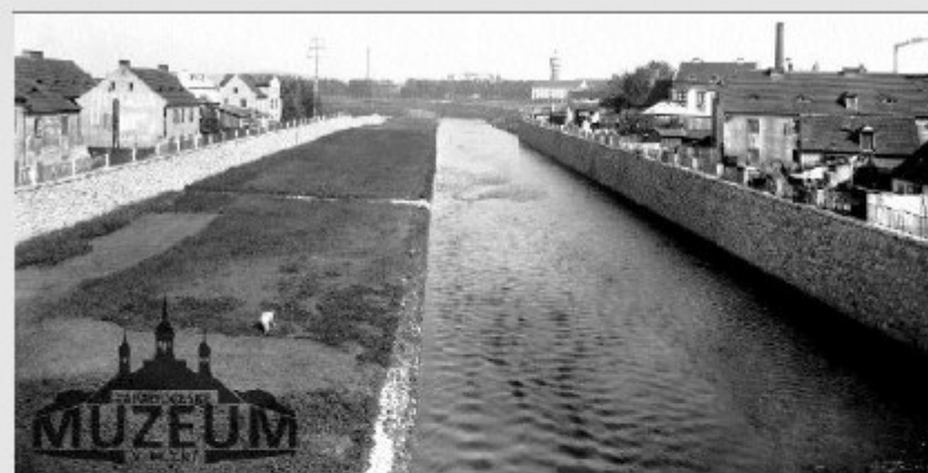
Regulované břehy Mže pod Saským mostem
