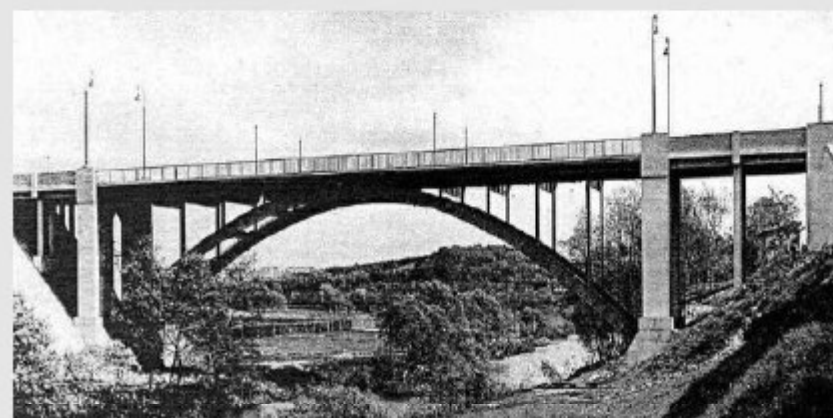
Tyršův most - první úplně svařovaný obloukový most na světě
