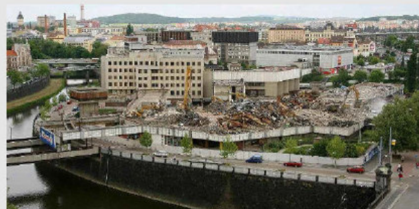
Demolice domu kultury na Denisově nábřeží roku 2012
