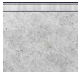
sokl tvoří světlý pohledový beton, zakončen řadou bílých cihel
