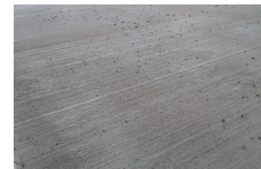
ŽELEZOBETONOVÁ RAMPA tl. 200mm PVRCHOVÁ ÚPRAVA-ČESANÝ BETON
