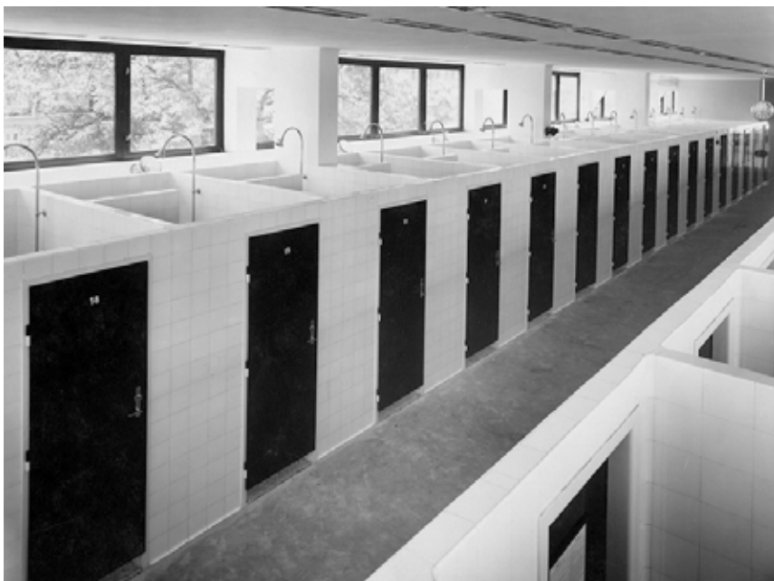
Mětské lázně v Brně - Zábrdovicích, Bohuslav Fuchs, 1932
