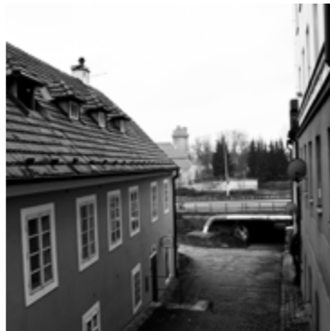
[6] podchod pod 4-pruhou Katovickou ulicí
