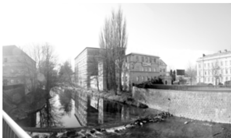
[2] řeka Volyně s továrnou Fezko - potenciální rozvoj
