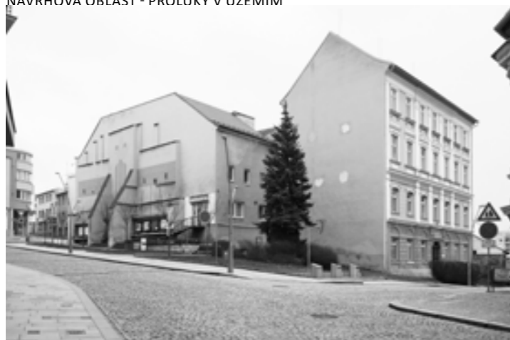
[1]chybějící nároží bloku na místě bývalé pošty
