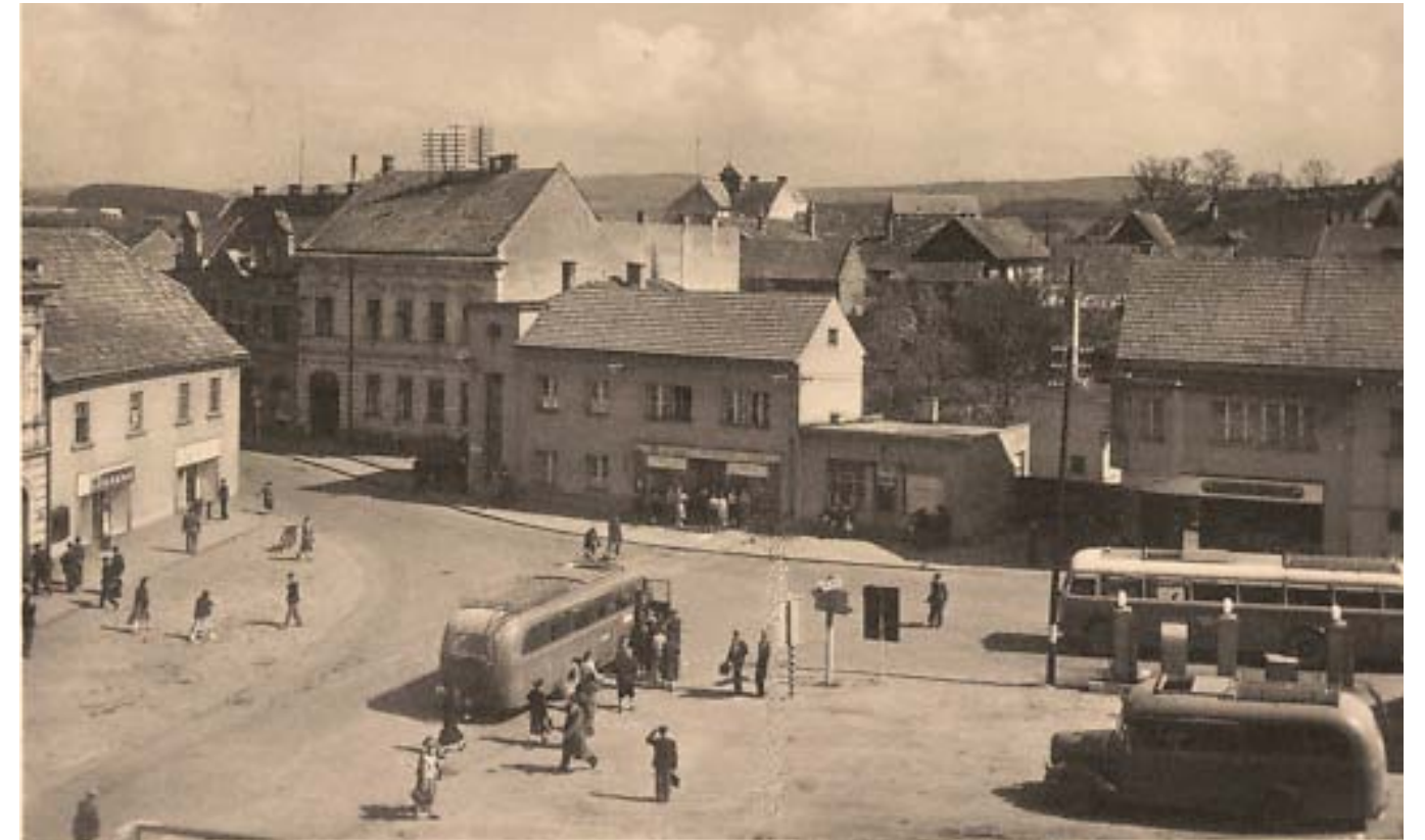
Pohled z budovy společenského domu Japis (dnešní polikliniky) na náměstí Mezi šenky s autobusovým nádražím a čerpací stanicí (50. léta 20. století)
