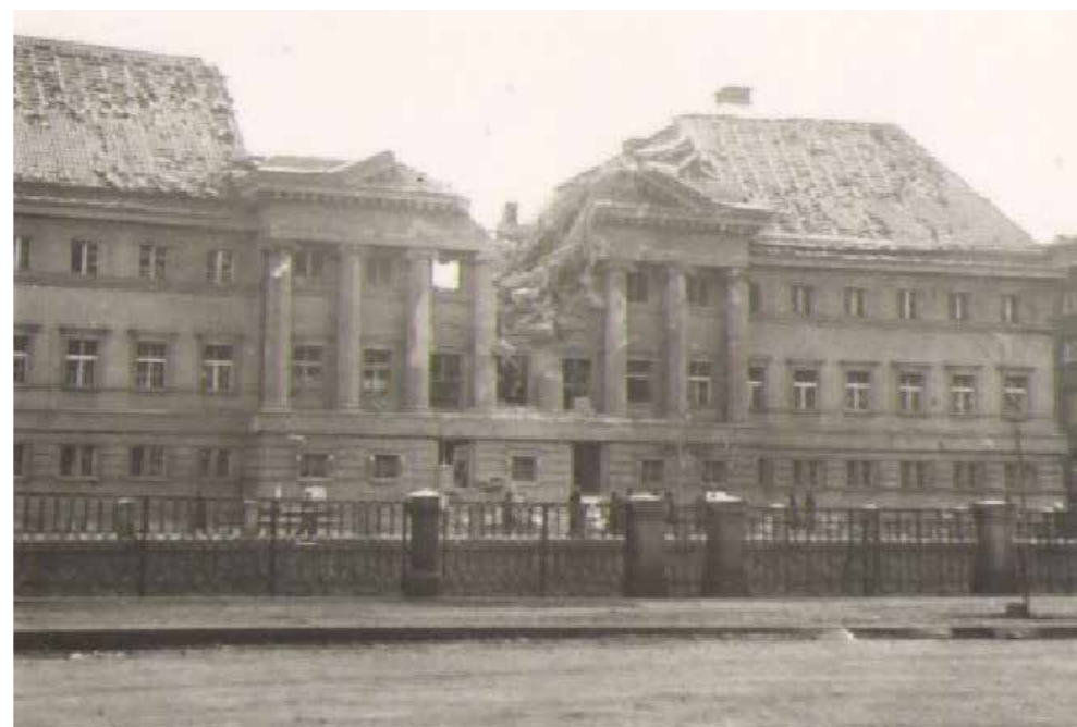
1944 - BUDOVA ZASAŽENA BOMBOU
