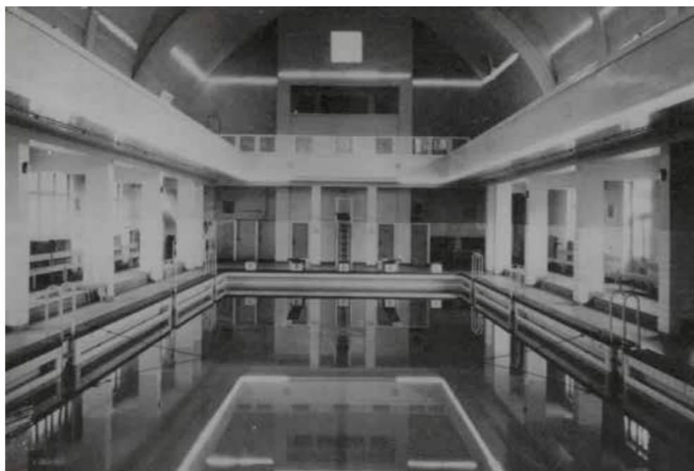
INTERIÉR BAZÉNOVÉ HALY - PŮVODNÍ
