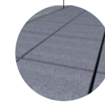
Betonová dlažba na náměstí
