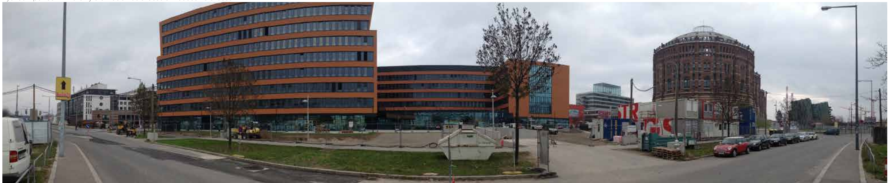
Severovýchodní pohled z ulice Modecenterstrasse
