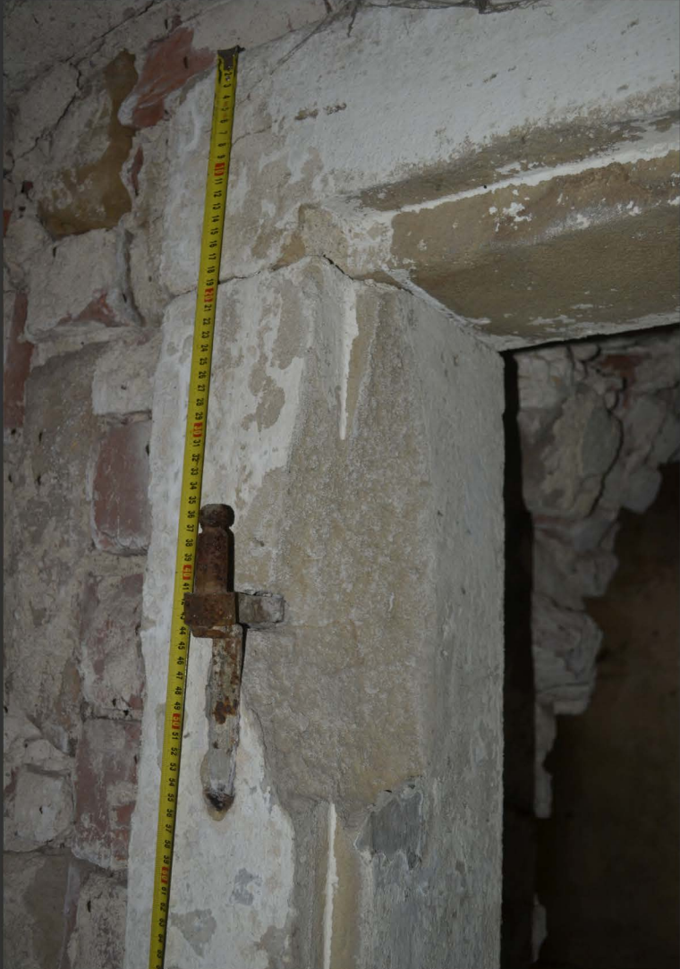
Ukázka inventarizace stavební prvků bude třeba před samotnou realizací provést důkladnou pasportizaci a analýzu prvků
