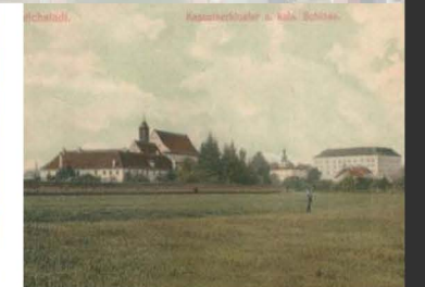
společný pohled na zámek a klášter
