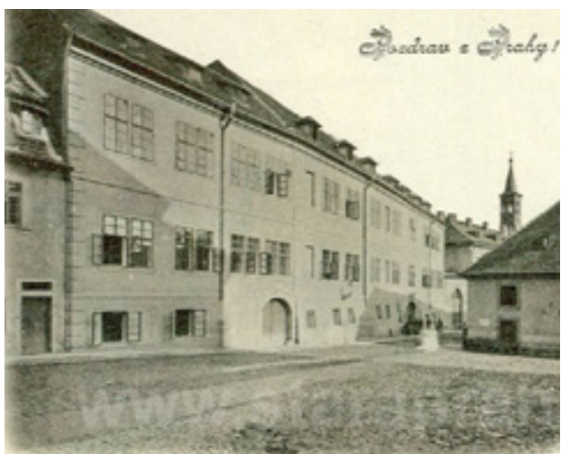
1900 - Kasárny v Brusce zbourány a roku 1922 nahrazeny transformační stanicí
