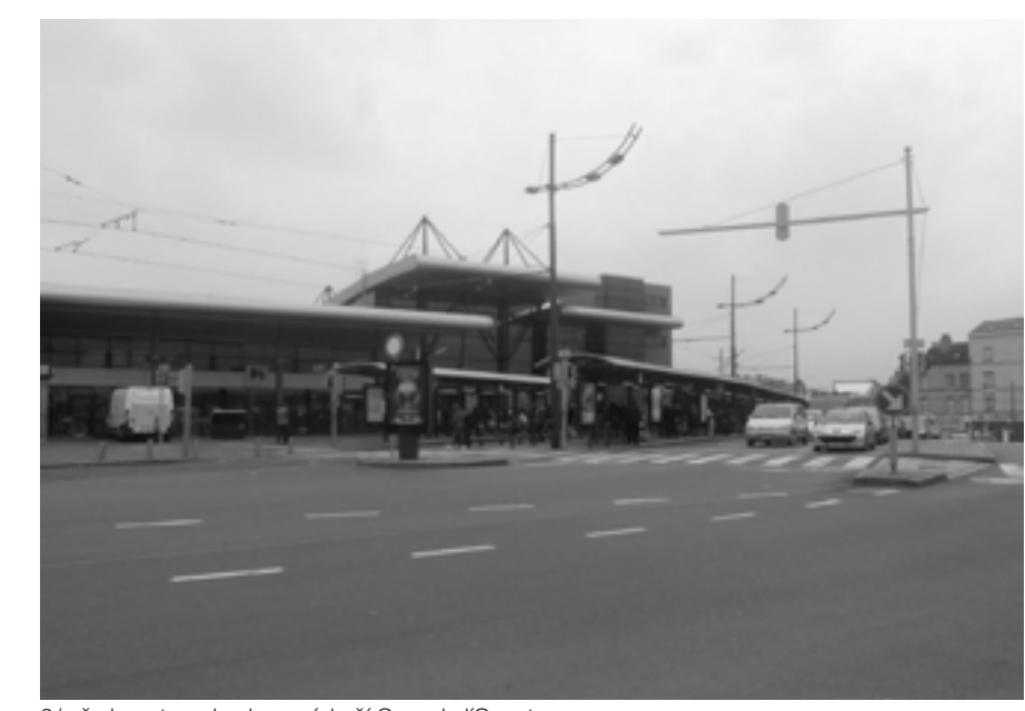
2/ předprostor a budova nádraží Gare de l'Ouest
