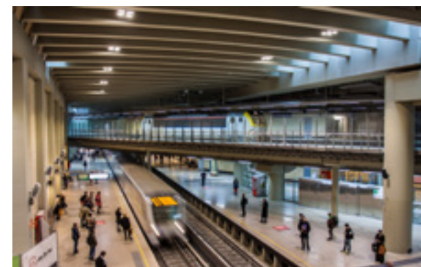
Křížení vlaku a dráhy metra, stanice Schuman, Evropská čtvrť, Brusel
