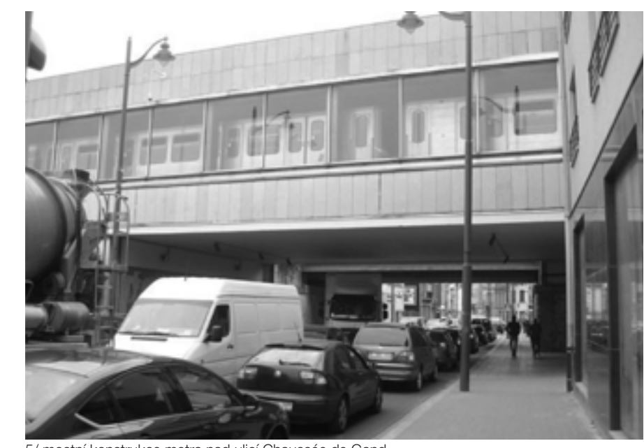
5/ mostní konstrukce metra nad ulicí Chaussée de Gand
