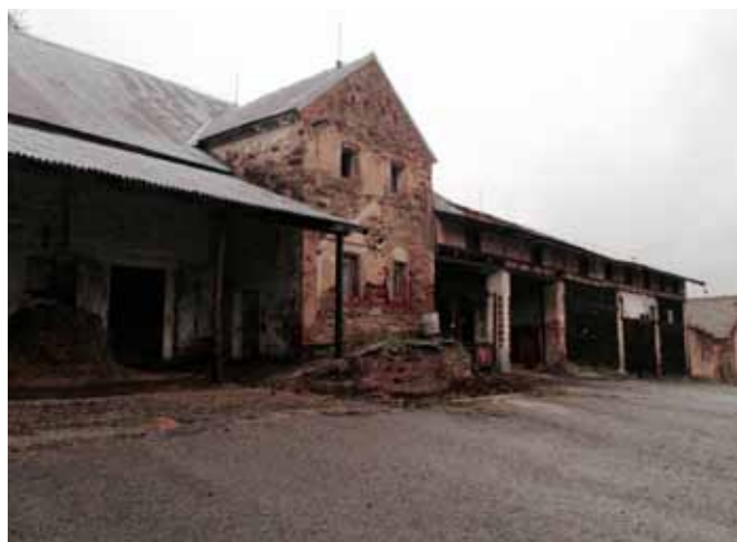
nejstarší část původního chátrajícího statku z hrázdné konstrukce, č.p. 3
