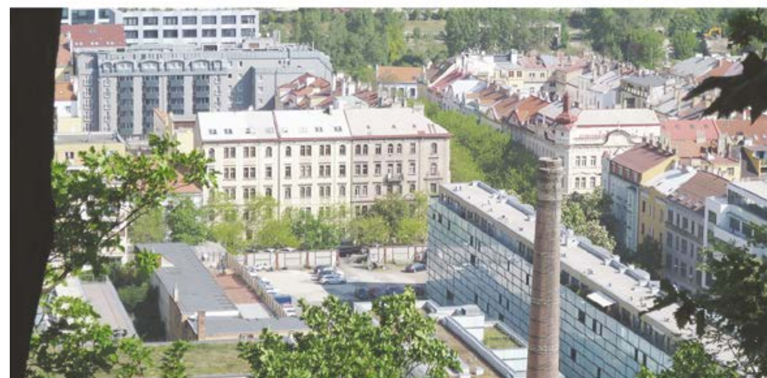
pohled na pozemek z Vítkova
