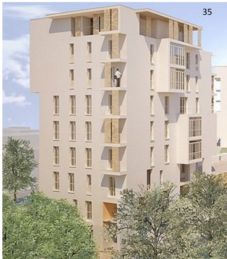
Itálie - Miláno, ve výstavbě 4 bytové stavby, 9 podlaží CLT panely, včetně šachet a schodišťových prostorů
