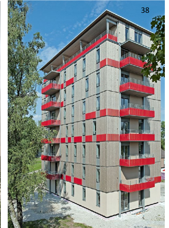
Německo - Berlín, realizace bytové stavby, arch. kancelář Kaden Klikgbeil 7 podlaží
