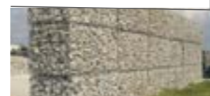
GABIONY opěrné zdi
