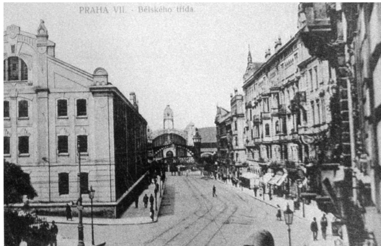
Pohled do ulice Dukelských Hrdinů směrem k výstavišti, Nalevo budova továrny Umrath, kolem r. 1910
