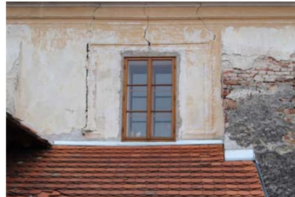
Detail kamenného ostění, okno do místnosti č. 105.
