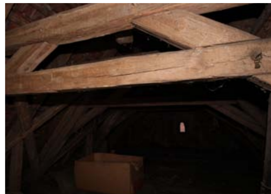
Celkový pohled na situaci rozpěry krovu severního křídla se skicou vazby.
