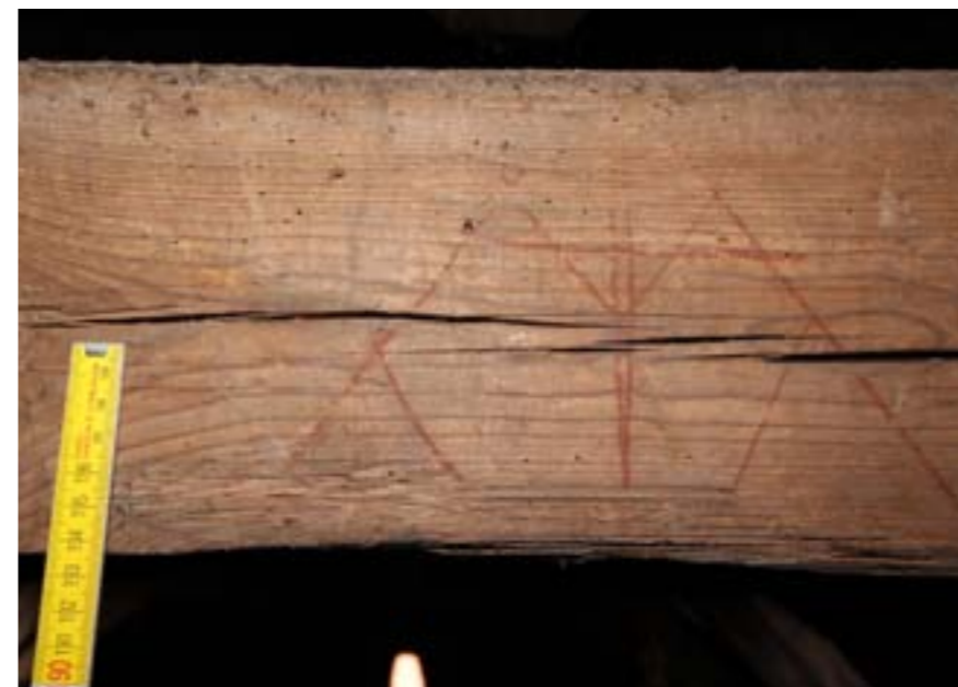
Skica na rozpěře ležaté stolice krovu severního křídla s rudkou malovanou skicou plné vazby krovu. Na skice patrná hambalková vazba s klasovitě umístěnými vzpěrami, typologicky odpovídající období pozdní gotiky.
