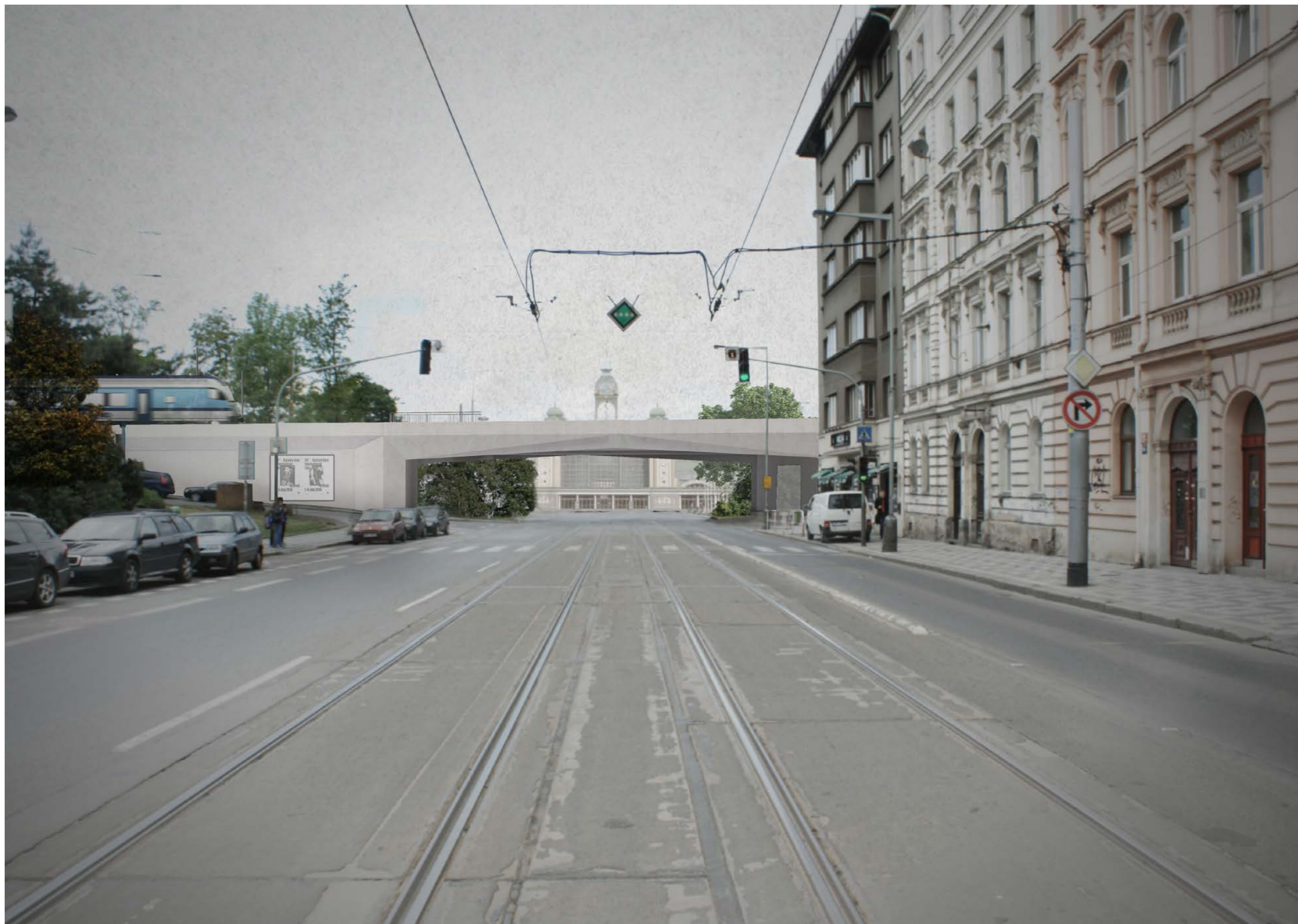
Ulice Dukelských hrdinů, přemostění ulice U Výstaviště
