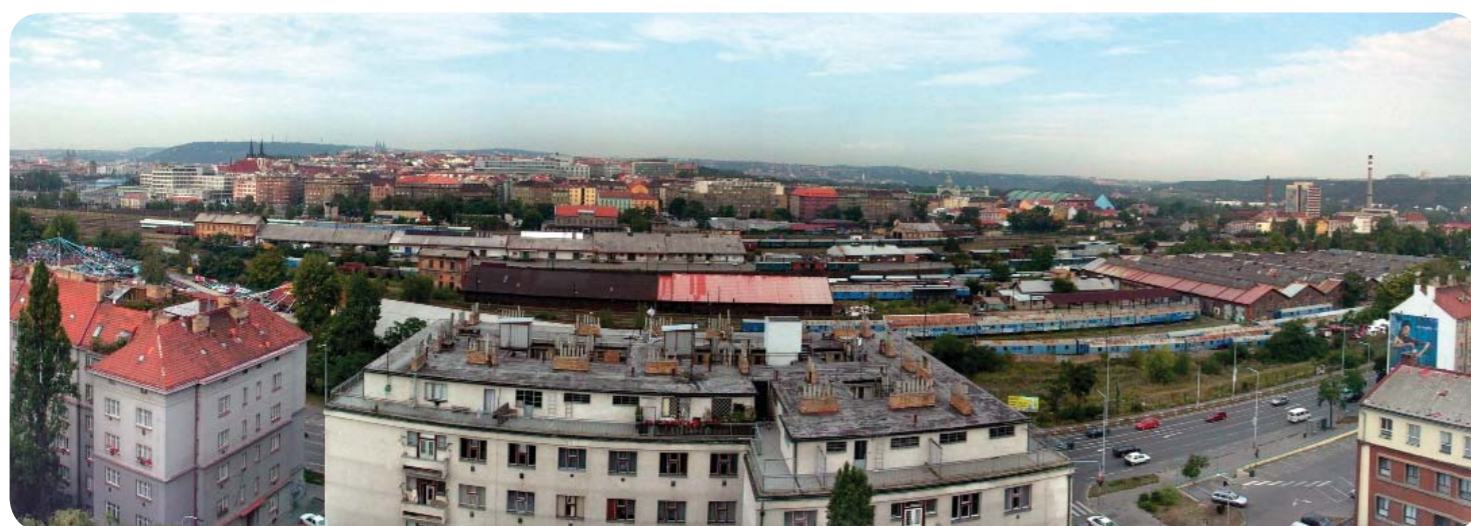
09 NÁDRAŽÍ BUBNY. Panoramatický výhled z dolních Holešovic na řešené území. V pozadí patrné množství zchátralých drážních budov, mnohé dnes však již bohužel nestojí. (foto zdroj: VCPD)
