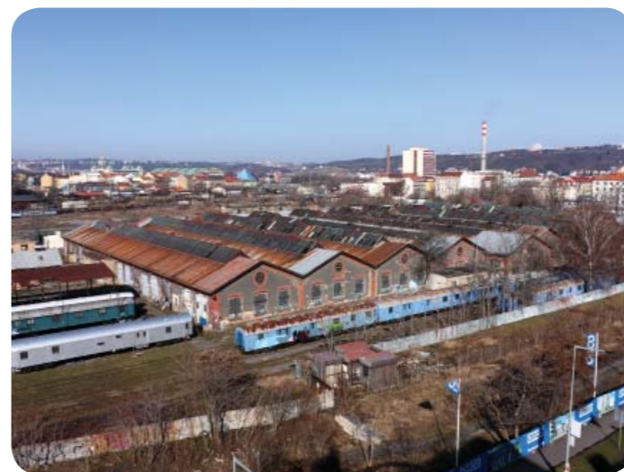
03 ŽELEZNIČNÍ DÍLNY. Historicky hodnotná devítitraktová hala z roku 1873 o rozměrech 65 x 160m. Dnes již téměř neslouží původnímu účelu - opravě vlakových souprav. (foto zdroj: VCPD)
