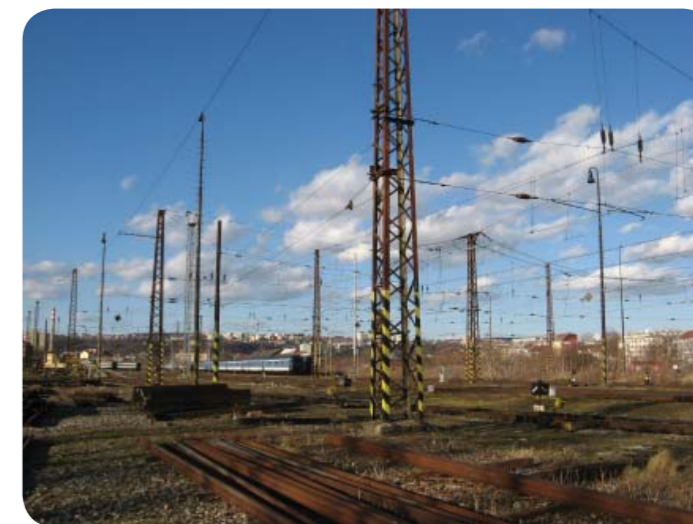
04 DRÁŽNÍ POZEMKY. Rozsáhlá část území spravovaná Českými drahami, které v současné době využívají jen jeho část.
