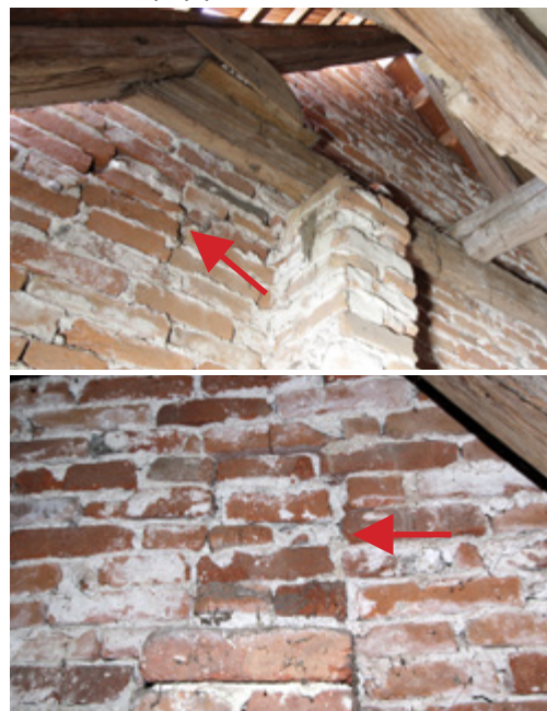
spára po zmenšení okenního otvoru
