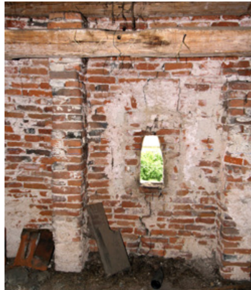
spára po zmenšení okenního otvoru
