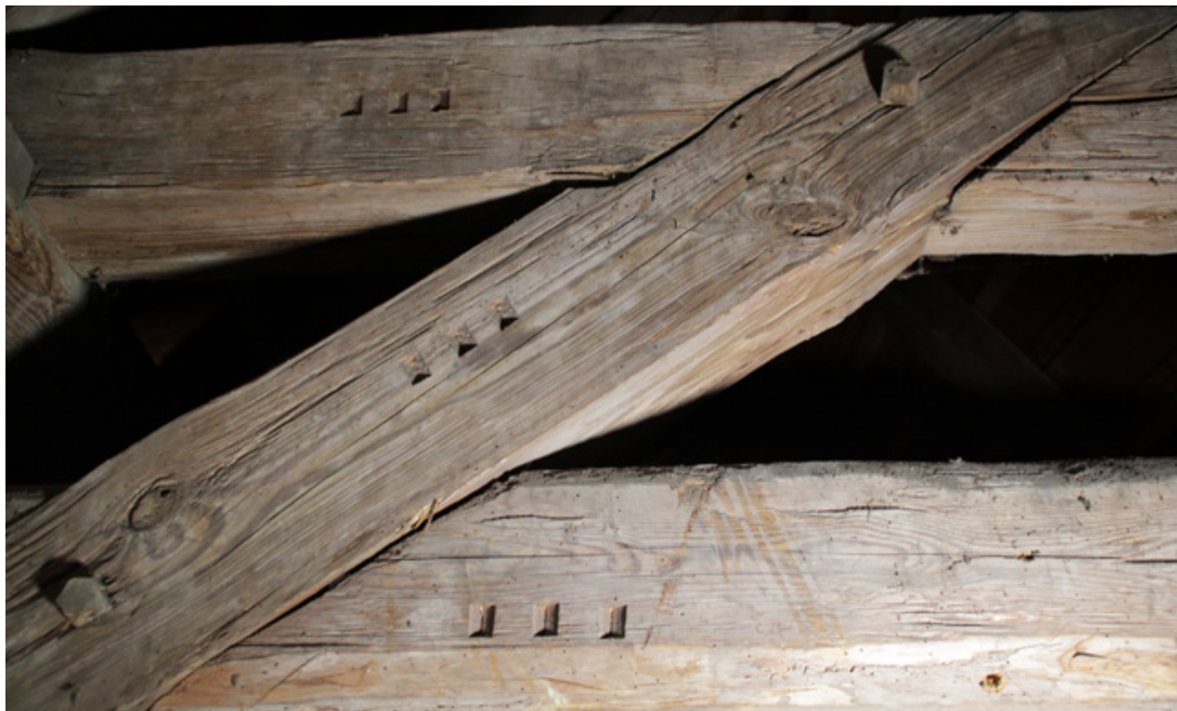
renesanční krov (severní křídlo)
