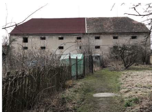
Provizorně zrekonstruovaná střecha
