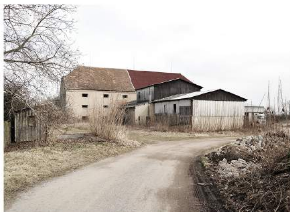
Pohled od fotbalového hřiště
