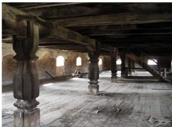
Pohled na trámový strop
