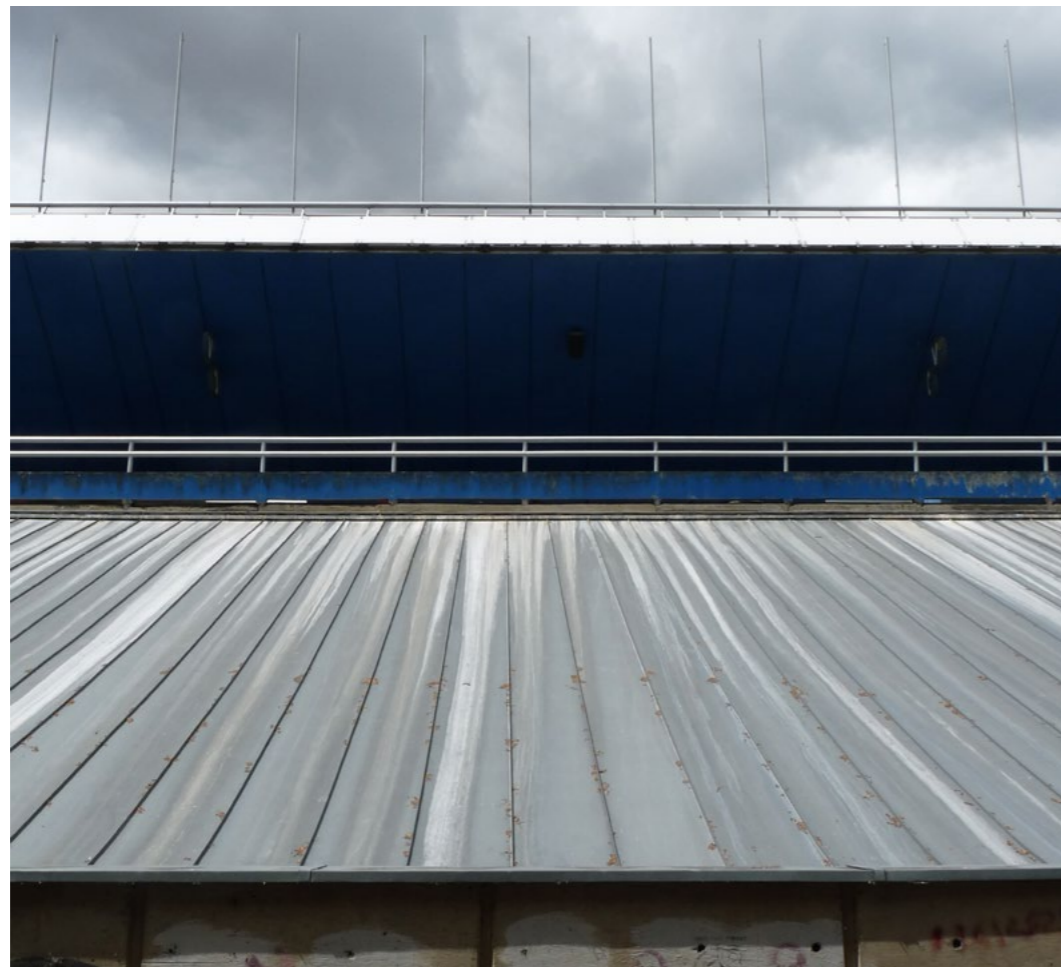
▲ Podzim 2016 pneumatická hala ležící na kururu centrálního stadionu
