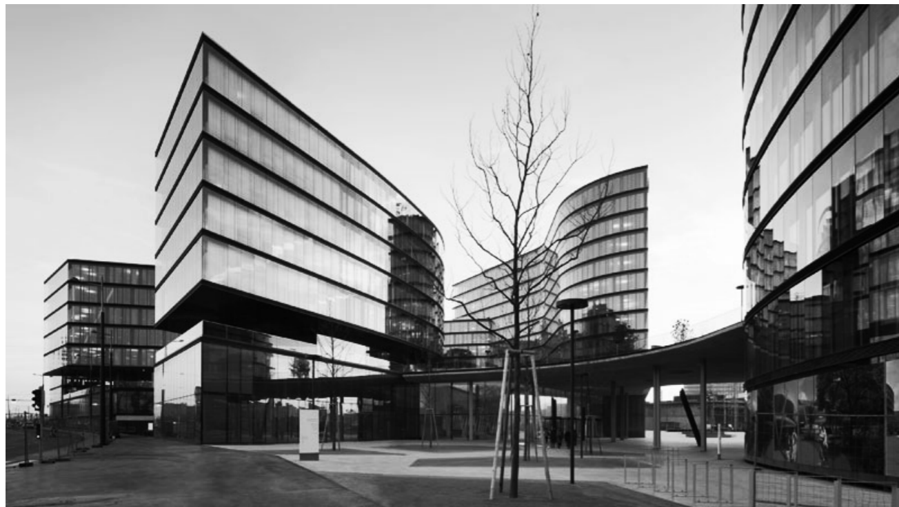
Erste Campus - úspěšná ukázka firemní architektury skupiny ERSTE ( zdroj : https://www.sparkasse.at )
