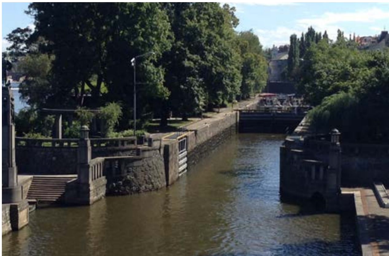
Pohled na severní cíp ostrova a komoru.
