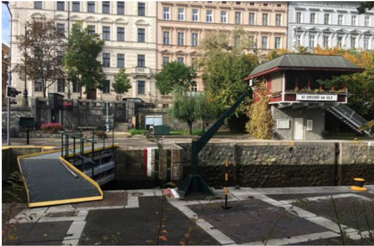
Západní část ostrova, komora.
