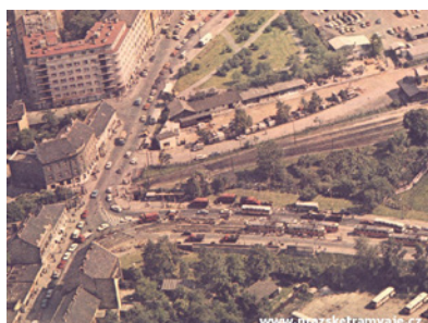
Křižovatka před výstavbou metra
